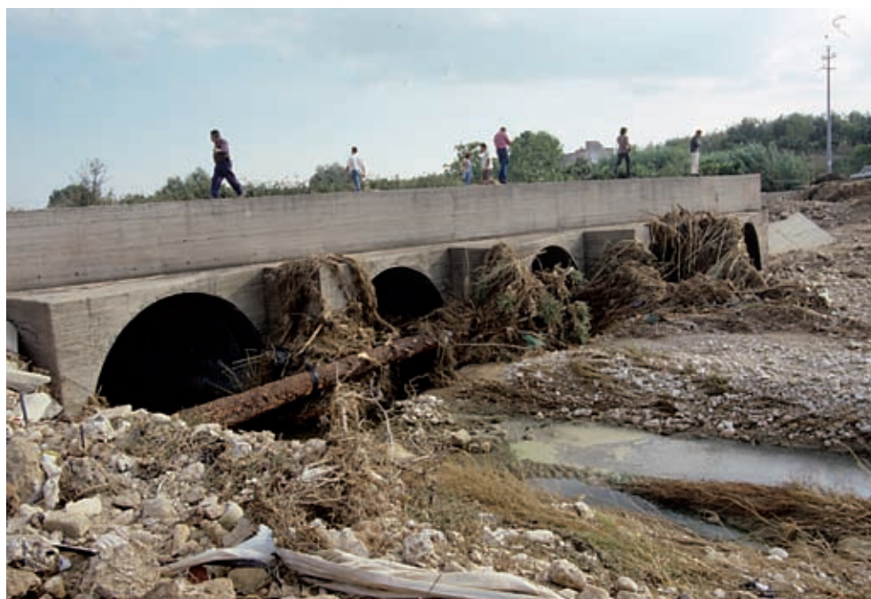
Fig. 6a – Effetti dell'alluvione del settembre 2003 nel territorio della provincia tarantina: tronchi di alberi e resti di vegetazione che occludono il passaggio al di sotto di una strada provinciale.
