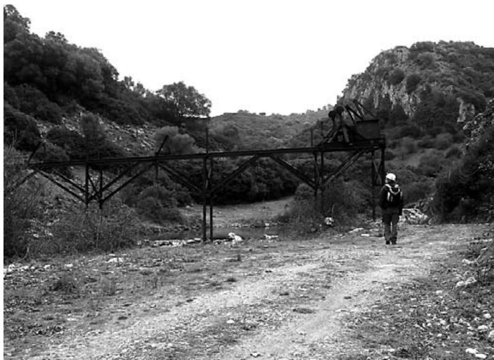
Fig. 3 – Il ponticello in ferro sul torrente Bau Adrussi, all’uscita dalla galleria nella miniera di piombo e fluorite di Ualla (Asuni), ormai dismessa. (Foto Laura Sanna)
