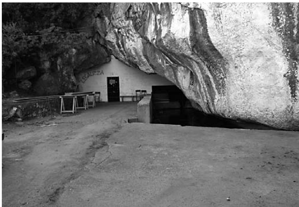
Fig. 8 – La captazione delle acque del sistema carsico di San Giovanni Su Anzu (Dorgali), sotto il Monte S'Ospile, ha determinato la chiusura di questa bellissima risorgente con una parete in muratura a sostegno di una cancellata. (Foto Giovanni Badino)
