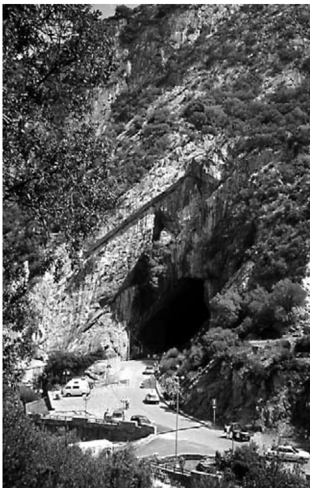
Fig. 6 – L'ingresso Sud della grotta di San Giovanni (Domusnovas, Iglesiente) con la strada asfaltata che la percorre per oltre 800 metri e, sulla sinistra dell'ingresso, le opere di presa della sorgente carsica.
