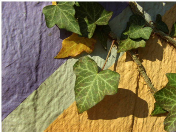
Abb. 17: Ungeplante Fassadenbegrünung auf Betonmauern der .... (A. JAGEL).
