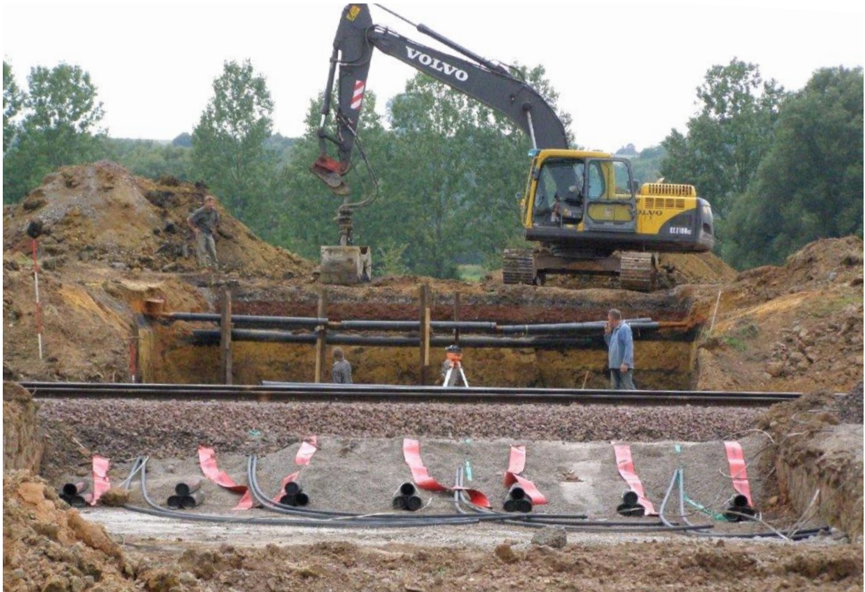
Abb. 13: Kabelgraben für sieben Systeme in Dreiecksverlegung; PFALZWERKE NETZ AG 2013
