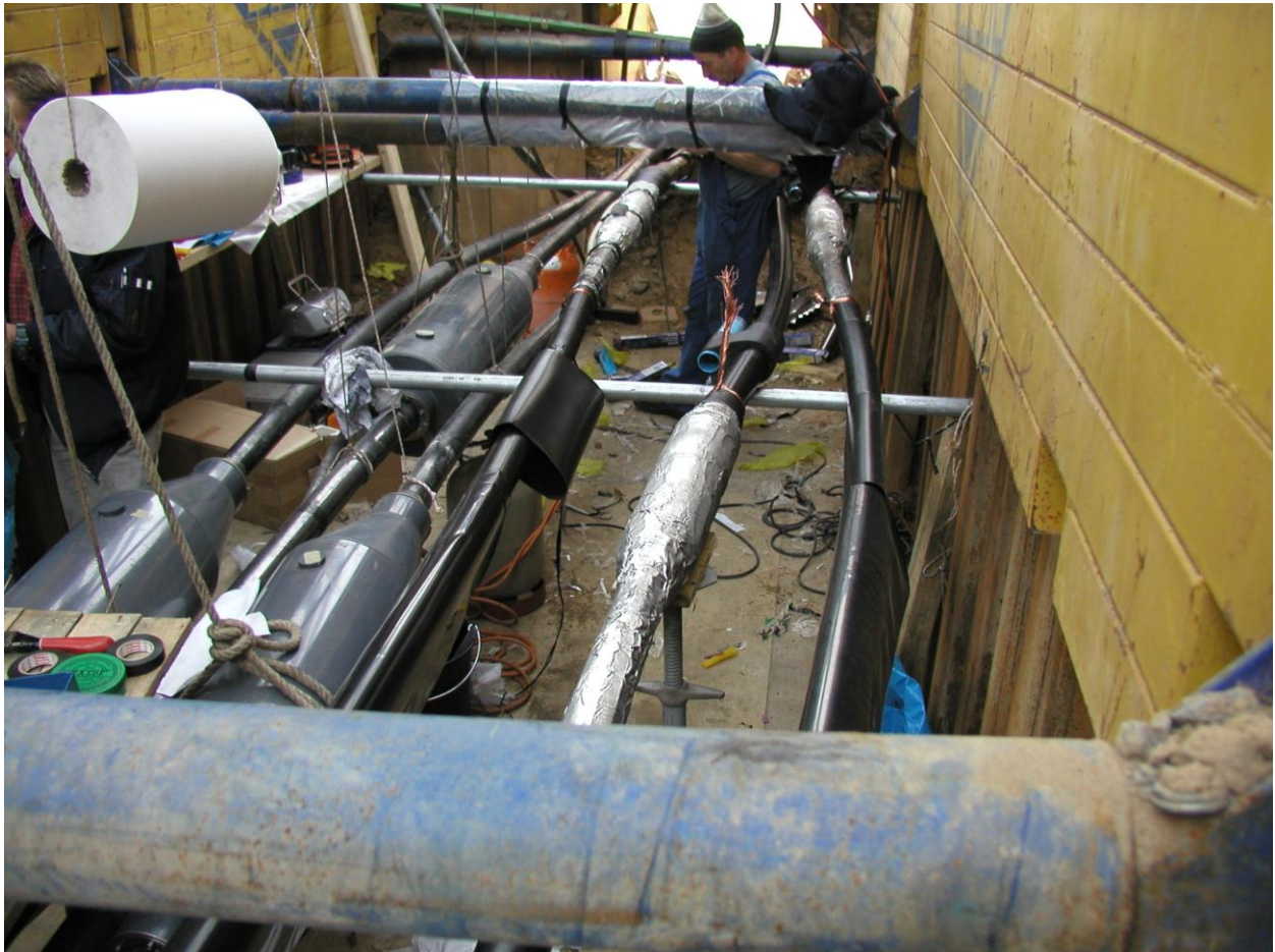
Abb. 14: Muffenbauwerk für zwei Systeme; PFALZWERKE NETZ AG 2013
