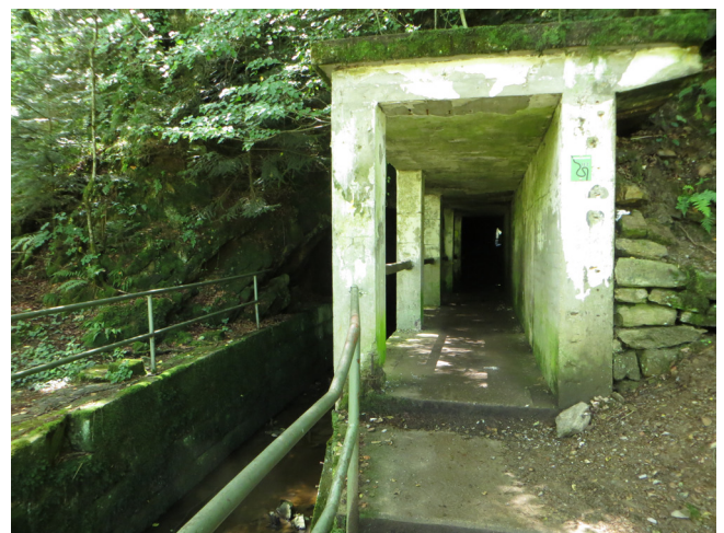
Abb. 4: Baudenkmal Trift-Tunnel (Foto: A. Zechmann)
