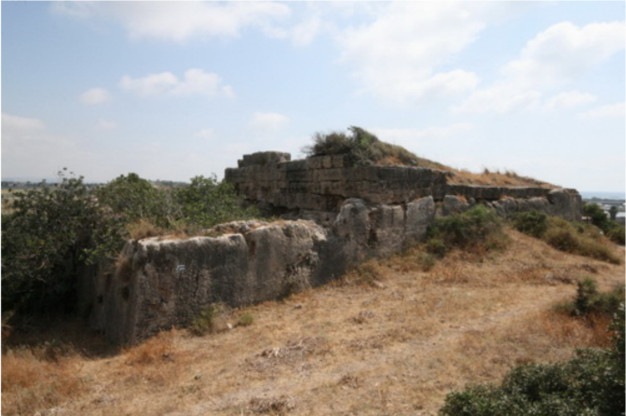
Atlit: Ansicht der Vorgängerburg le Destriot von Nordosten. Der Felsenblock stellt den Sockel eines donjonähnlichen Turmes dar. Er wurde abgebrochen, um Material zur Errichtung der Pilgerburg zu gewinnen.
