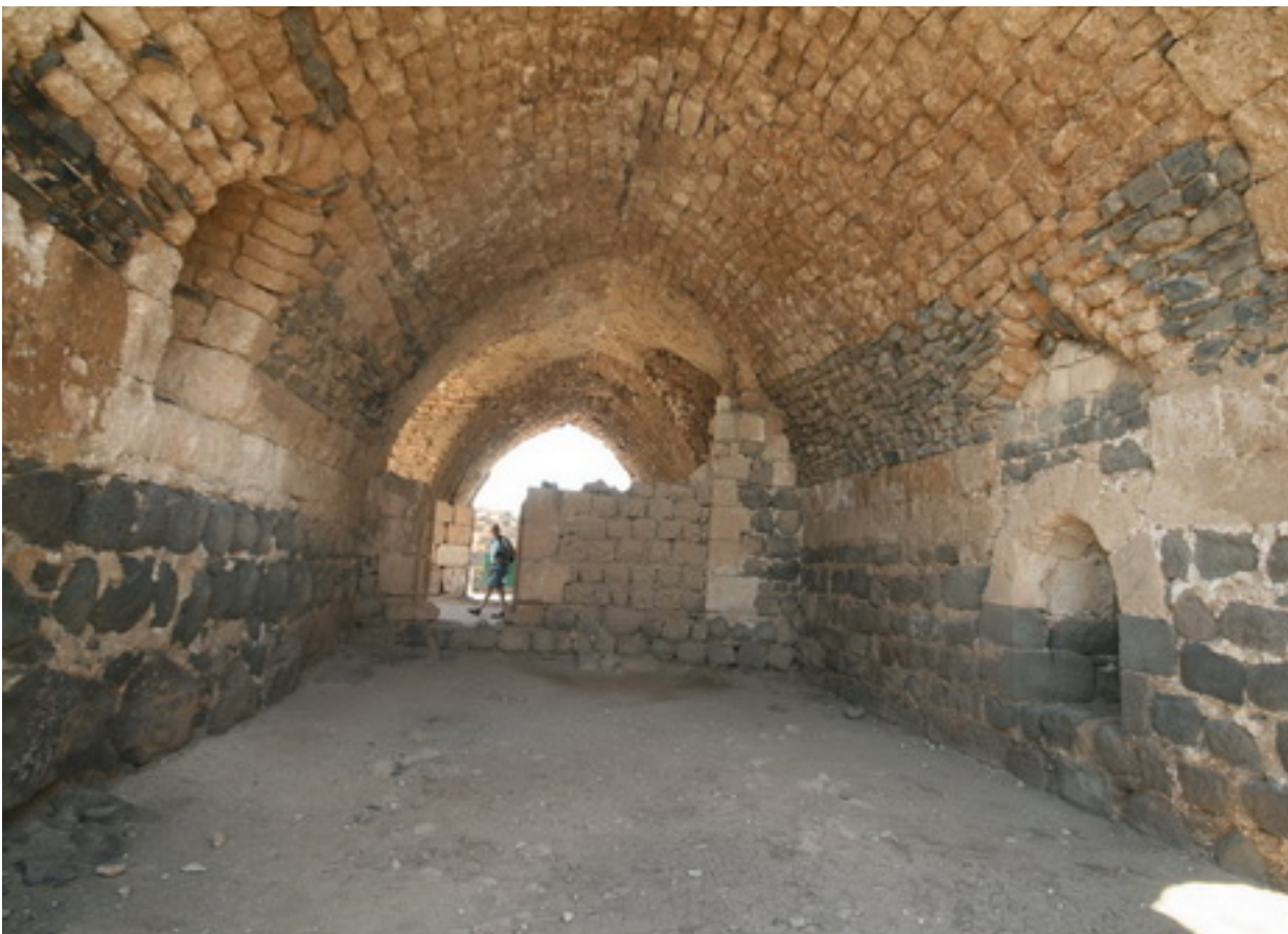
Belvoir: Halle im inneren westlichen Wall. Als Schmuck wurden weiße Kalksteinquader im Kontrast zu den dunklen Basaltblöcken gesetzt.
