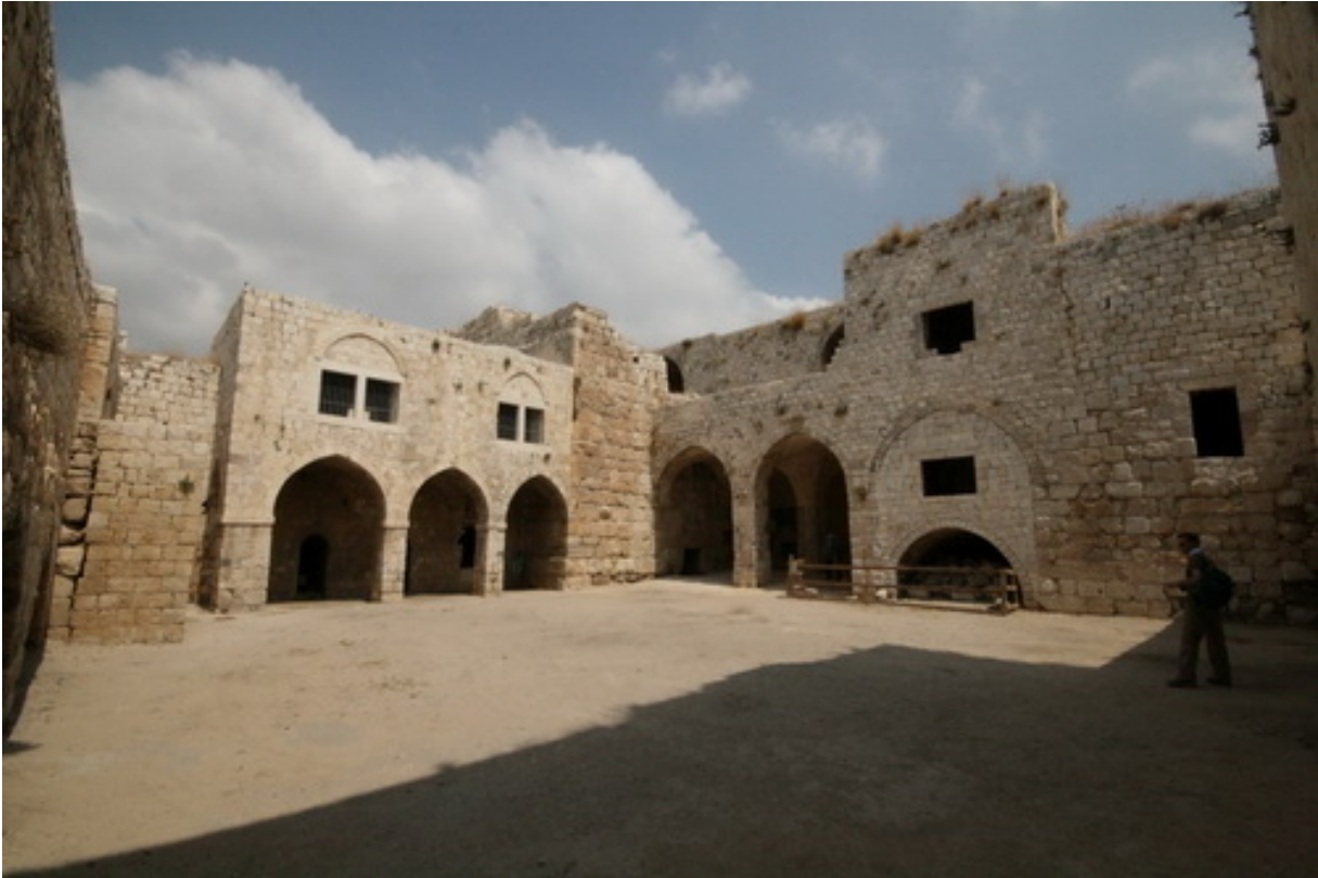
Mirabel. Innenhof. Deutlich zeichnen sich die osmanischen Einbauten durch kleinformatige Quader von den Kreuzfahrerbauten ab.
