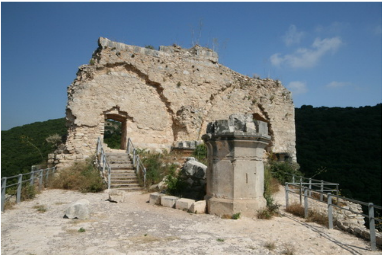
Montfort: Ruine des Rempters. In der Mitte ist der gut erhaltene achteckige Pfeiler zu erkennen. Die rückwärtige Mauer aus kleinformatischen Quadern ist dem Vorgängerbau zuzuordnen. Die Gewölbeansätze wurden nachträglich eingearbeitet.
