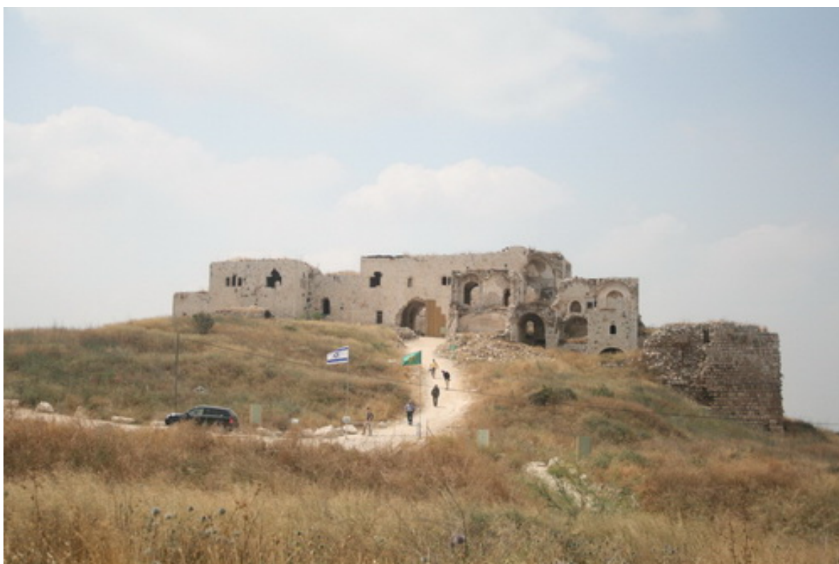
Abb. 4: Mirabel. Gesamtansicht der Burg.
