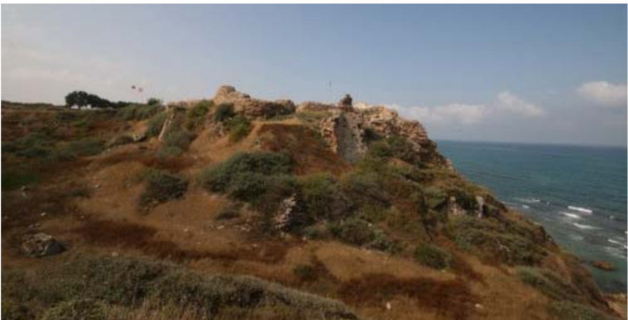
Arsuf. Ansicht von Norden..
