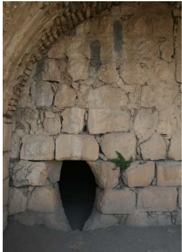
Qal'at Subeibe: Südturm des Westriegels. Die fränkische Mauer wurde durchbrochen um Zugang zur muslimischen Ummantelung zu gewinnen.
