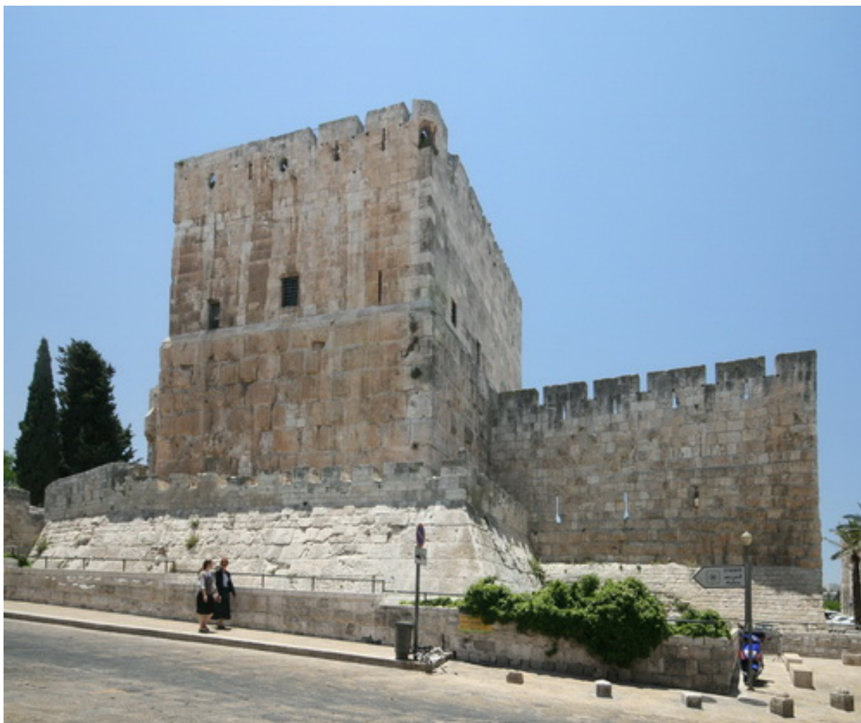
Jerusalem Davidsturm. Am Turm ist der antike Sockel des herodianischen „Phasaelisturm“ aus Großquadern gut von den mittelalterlichen Aufbauten zu unterscheiden.
