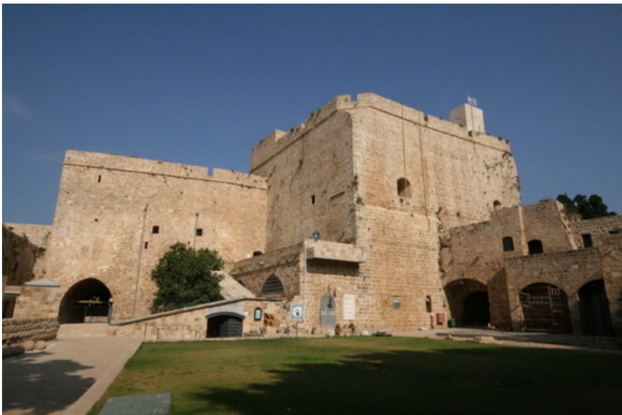
Akkon: Osmanischer Festungsbau über dem Johanniterkomplex. Zu seiner Stabilisierung wurden die mittelalterlichen Gewölbe im 18. Jh. Zugeschüttet.
