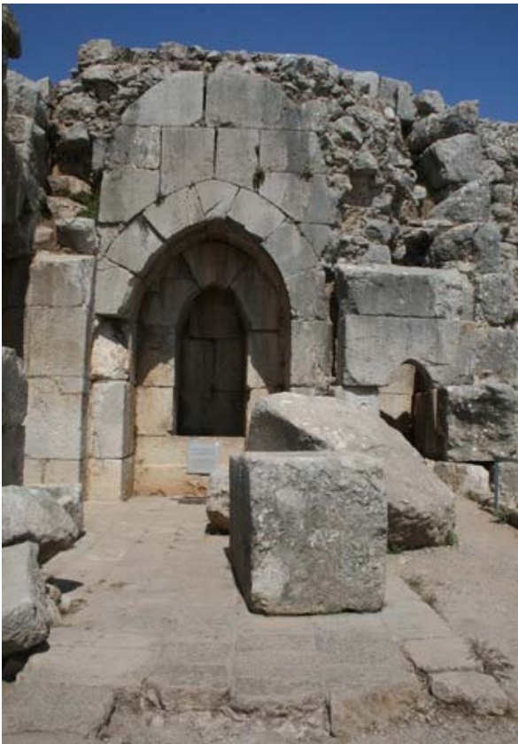
Qal'at Subeibe: Zugang zur kleinen Zisterne in der Unterburg.
