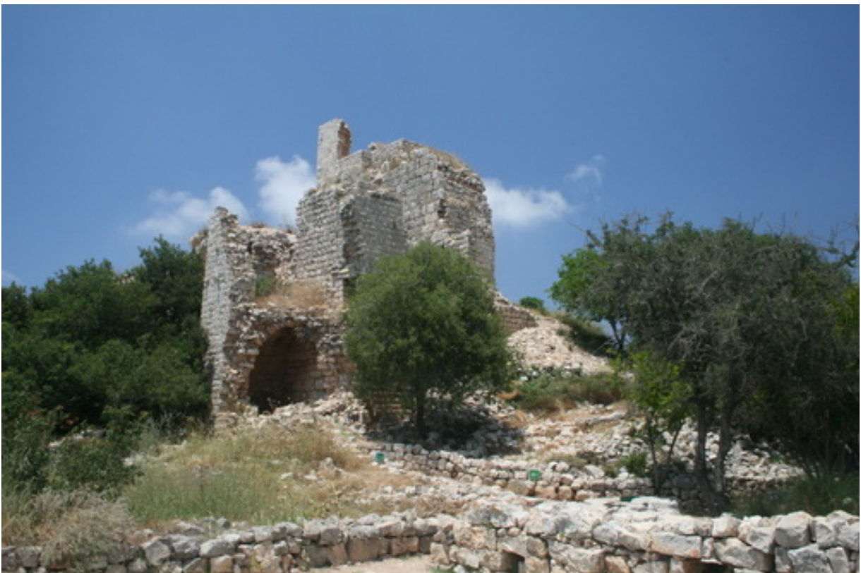
Judin: Ostturm von Südosten. Das großformatige Mauerwerk ist mittelalterlich. Die Bauteile aus kleinformatigen Quadern stammen aus osmanischer Zeit.
