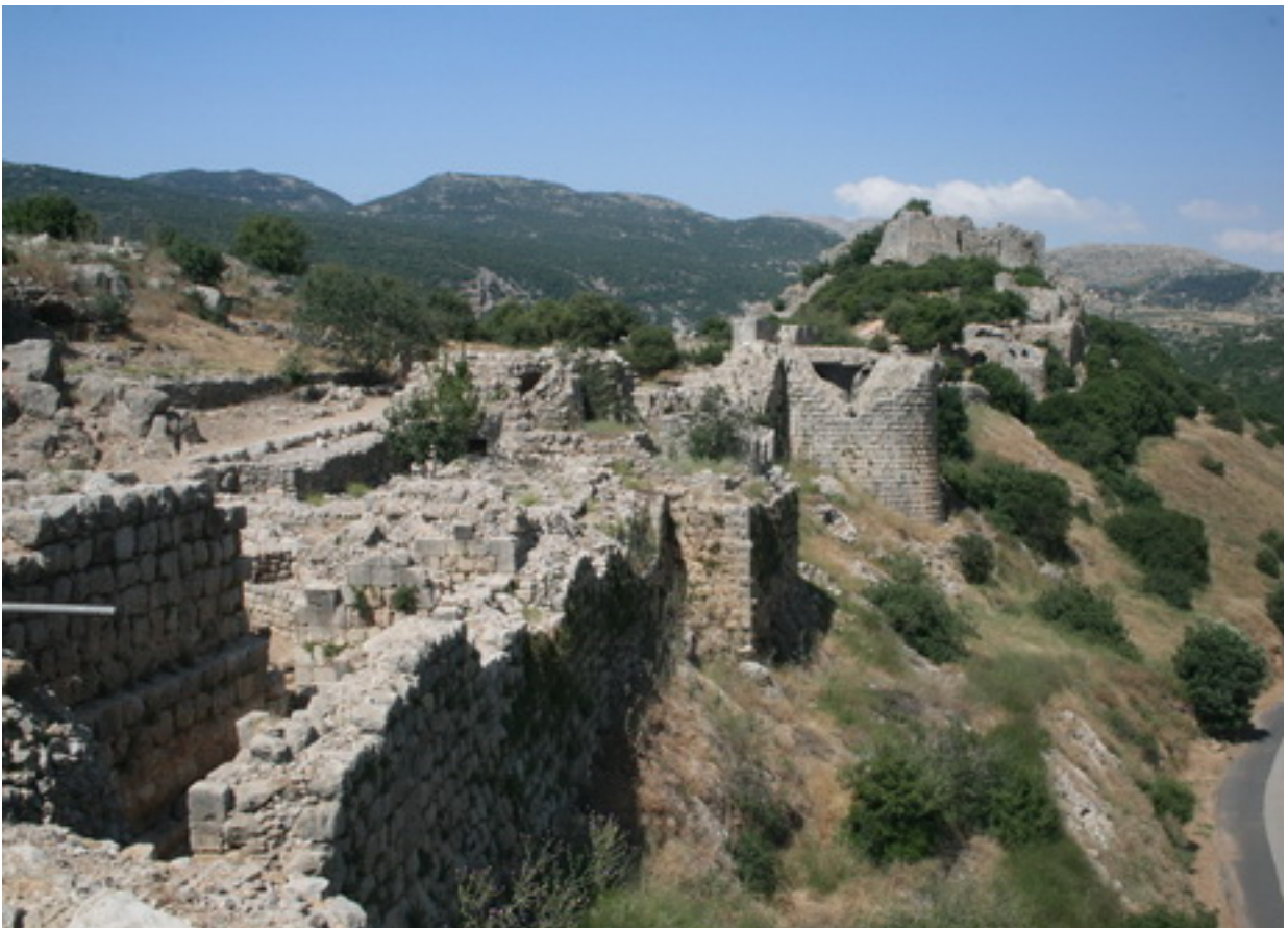
Qal'at Subeibe: Südmauer der Unterburg mit Blick zur Zitadelle.
