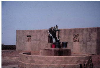
Figure 9 : Puits à margelle fermée
