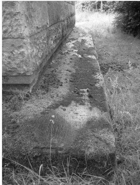
Figuur 1. De onderbouw (het pompgebouw) van de voormalige watermolen bij de vijver van het Jachthuis Sint Hubertus op de Hoge Veluwe tijdens een regenbui (foto links): het water stort over de daklijst naar beneden op de zandstenen bodemplaat. Op de bodemplaat is duidelijk de zonering zichtbaar (foto rechts) van Oeverdikkopmos ( Brachythecium plumosum ; lichte zone aan muurkant) en Spettermos ( Blindia acuta ; donkere zone aan buitenkant). Zowel de bodemplaat als het onderste deel van de muur zijn van Maulbronner zandsteen (foto's: Rienk-Jan Bijlsma, 2007)
