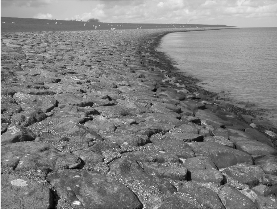
Figuur 1. Granieten zeedijk langs de Eems bij Delfzijl (foto: Kok van Herk)
