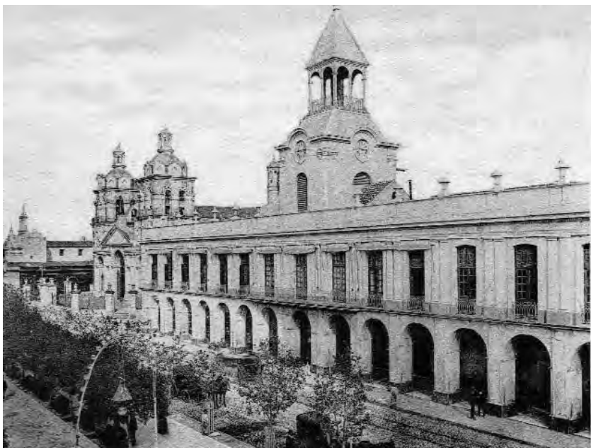
Fig. 75. Cabildo de la ciudad de Córdoba a fines del siglo XIX cuando ostentaba la torre construida por Mariano Güell
