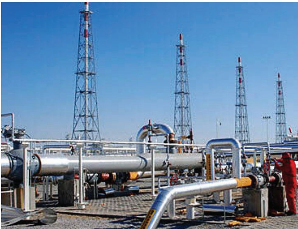
Рис. 1. Блок входных коллекторов
