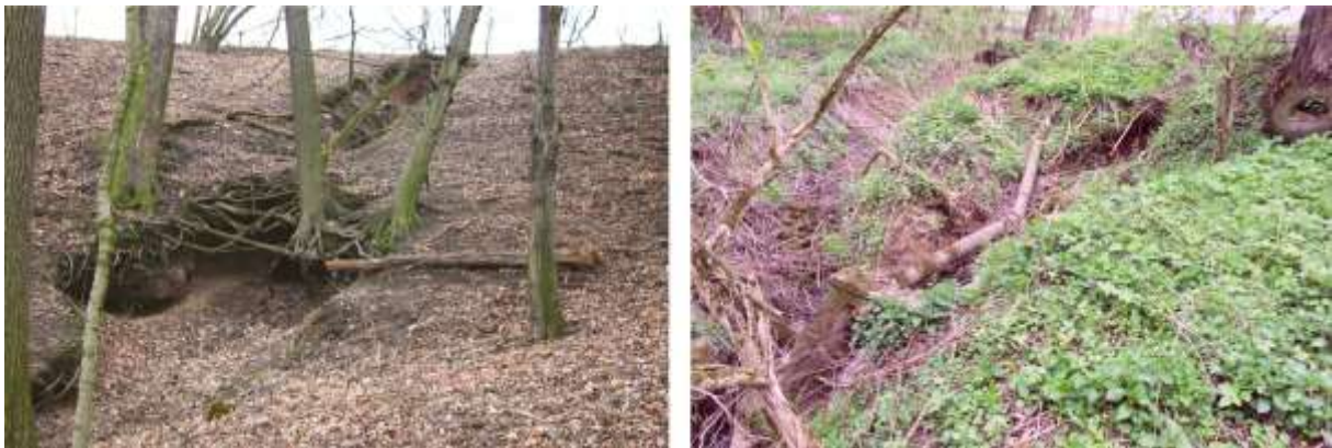
Obr. 6 Příklad intenzifikace eroze pod výústí částí POZ následkem odtoku z přívalových dešťů (vlevo) a destrukce neudržovaných HOZ a POZ (okr. Ústí nad Orlicí, r. 2018 a 2015)
