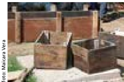
Moldes listos para ser colocarse.
