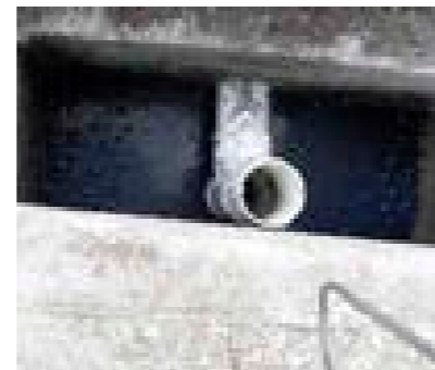
Conector "T" como respiradero en la trampa de grasas.
