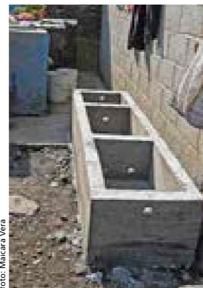
El filtro casi terminado.
