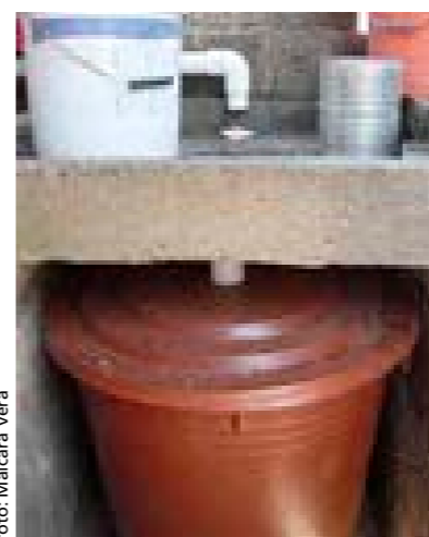
Filtro vertical instalado bajo el lavadero.
