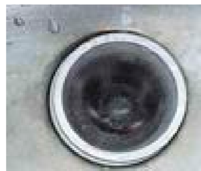
Coladera para evitar basura en el filtro.
