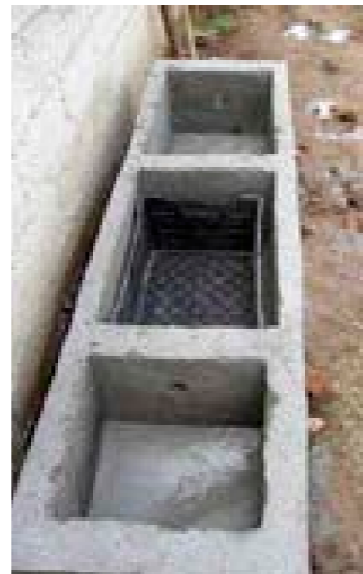
Filtro horizontal con una de las canastillas de plástico.
