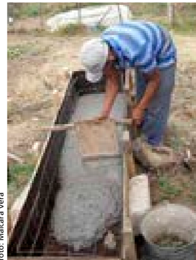
Extendiendo la mezcla de cemento para el firme.
