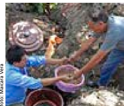
Colocación de las canastillas con material filtrante.
