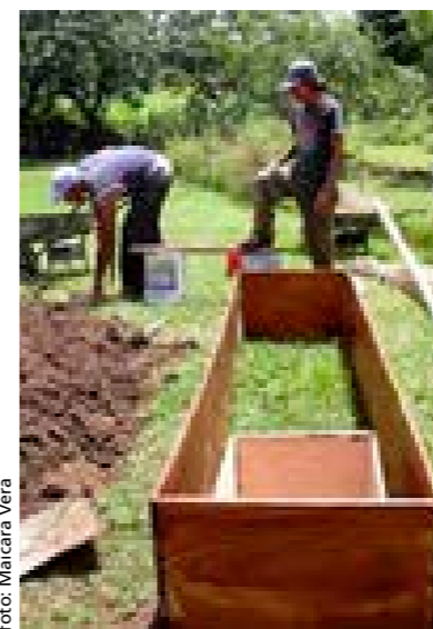
Presentación del molde exterior y uno de los moldes interiores.
