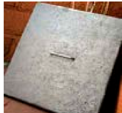
Tapa de uno de los registros. También puedes fabricar las tapas con plástico reciclado (ver referencia donde se compra el material en sitios de interés al final de este manual).
