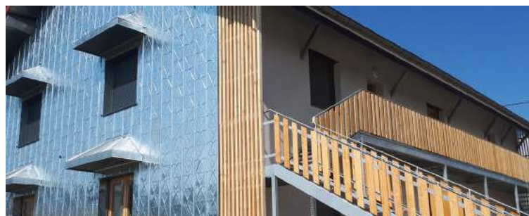
Chalets des Janiers - PRENOVEL - NANCHEZ
