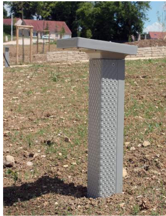
Extension des réseaux zone d'habitation - AUTHUME
