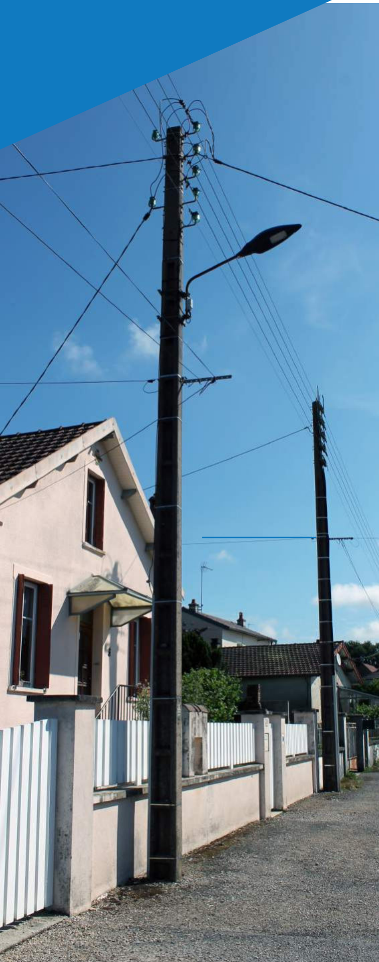
Enfouissement et renforcement des réseaux - CHAISEY
