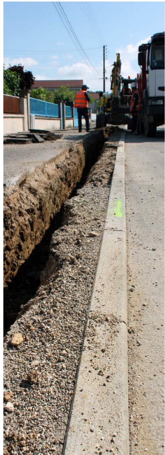
Enfouissement et renforcement des réseaux - CHOISEY
