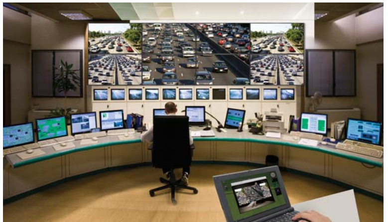
Sala de control
