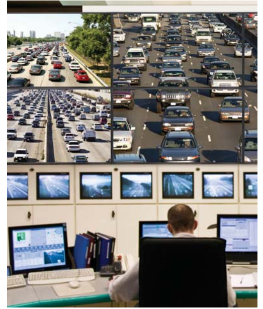
Instalación Sala de control
