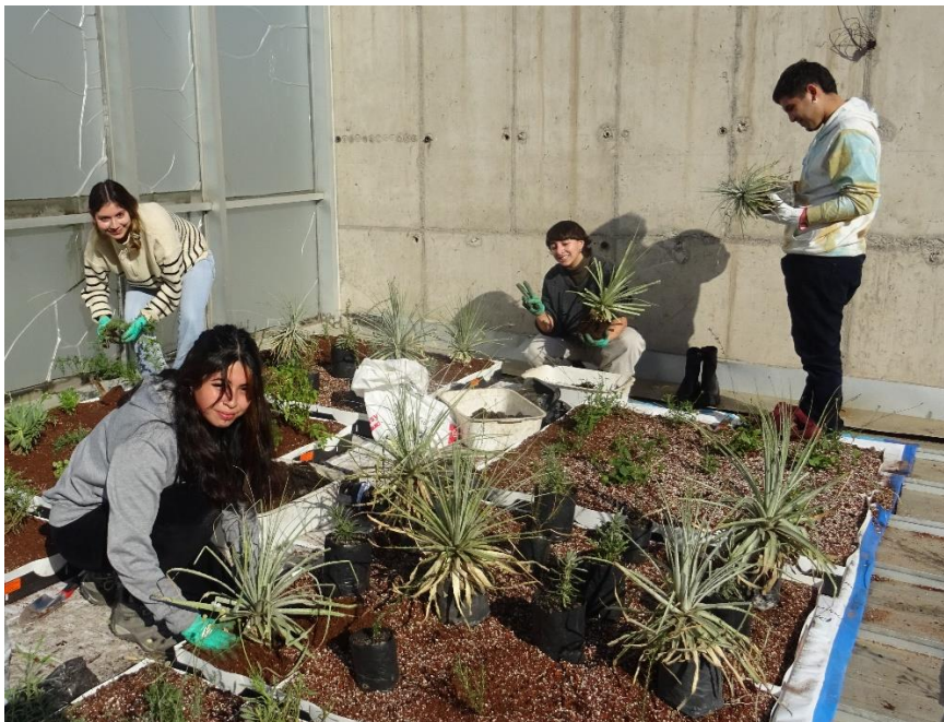
Figura 1. Activa participación de los estudiantes de Arquitectura del Paisaje en construcción y mantención del techo verde.
