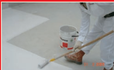
1. Application of Primer coat
