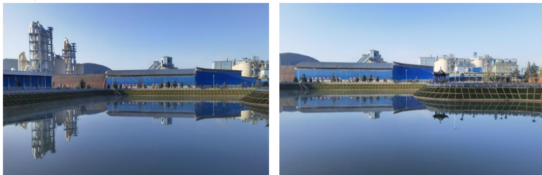
云南兴建水泥雨水收集循环水池项目
