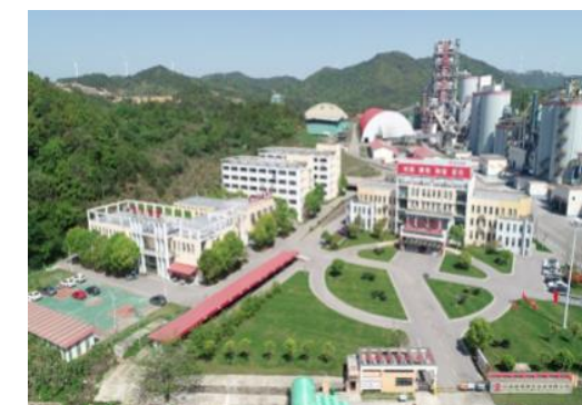
江西南城南方水泥水泥窑协同处置固体废弃物项目
