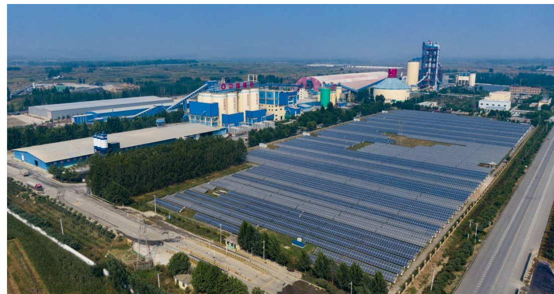
临沂中联6.5兆瓦分布式光伏并网电站
