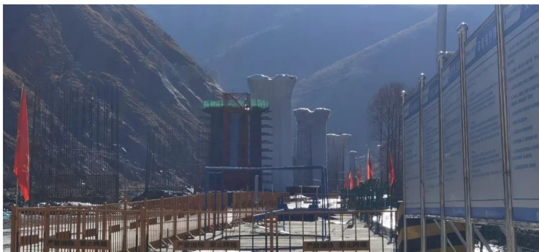
川藏铁路瓦泽1号特大桥桥墩施工现场
