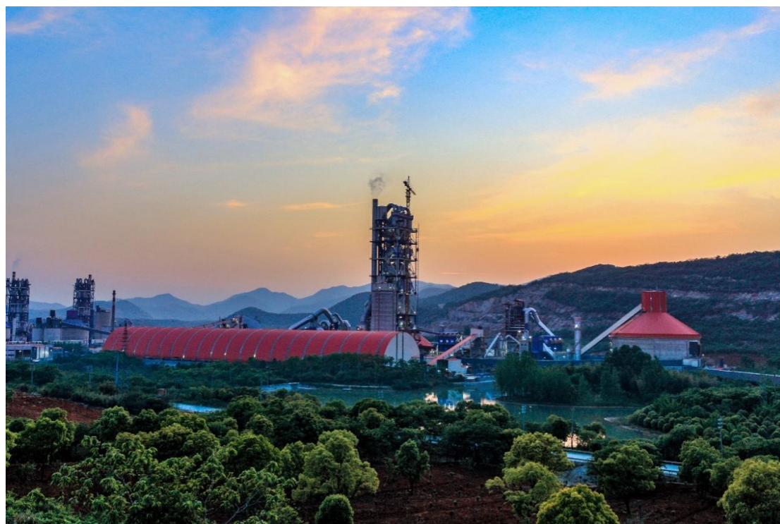
槐坎南方水泥熟料生产线
