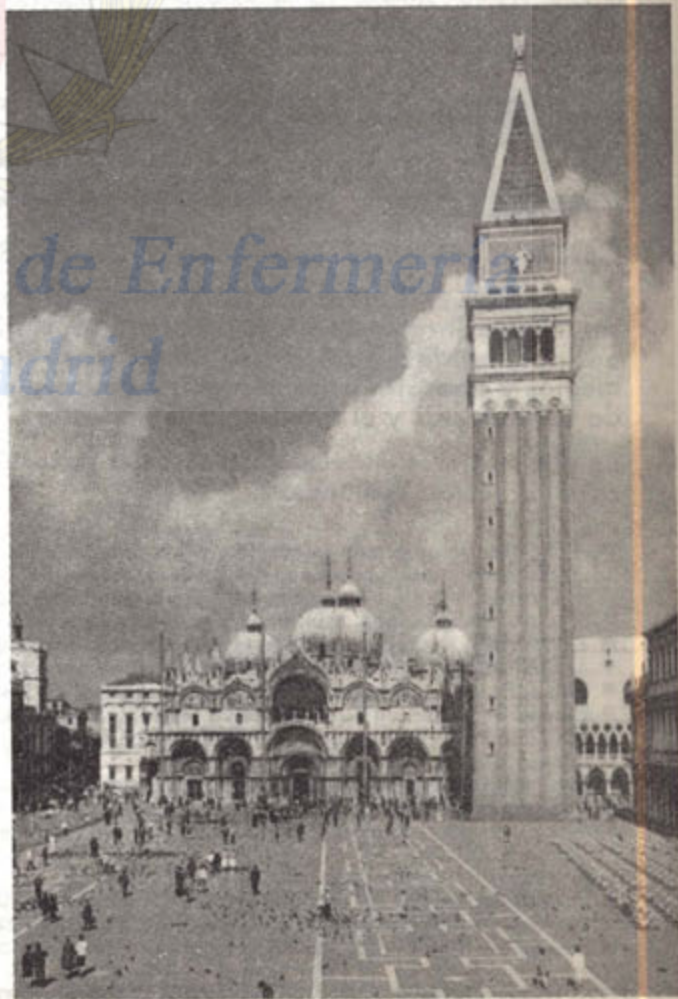
VENECIA.—La plaza de San Marcos. Al fondo el Duomo; a la derecha el “campanile” moderno (el antiguo se derrumbó en 1902).
