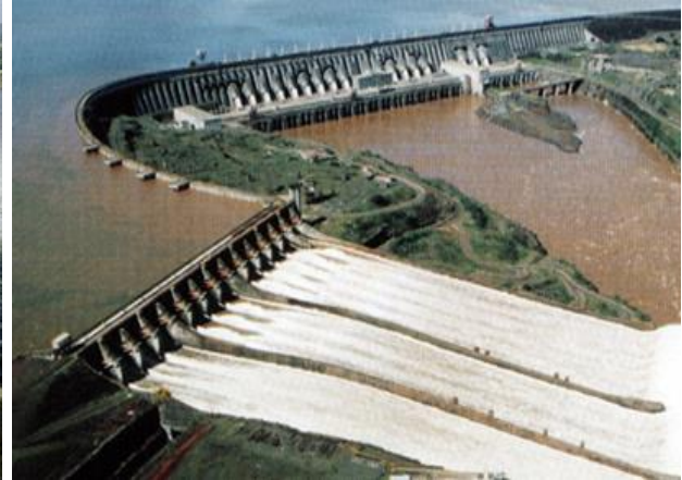
Figura 45. Usina de Itaipu Fonte: COPEL
