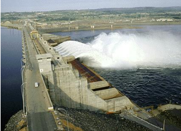
Figura 44. Usina de Foz do Areia Fonte: COPEL
