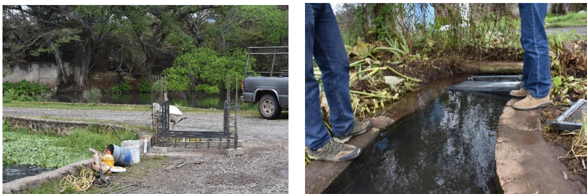
Figura 6.21. Construcción y colocación de mallas para contención de especies exóticas en el río Teuchitlán.
