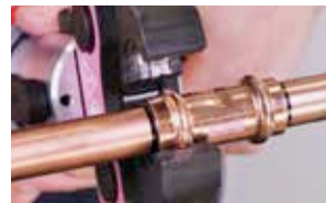
9. Lijn de klemmen recht uit op de fitting
