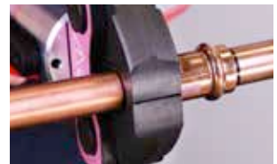
10. Maak de verbinding af met het goedgekeurde gereedschap. Pers slechts een keer
