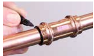
7b. Plaats, bij wijze van alternatief, de buis in de buisstop en breng een
