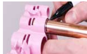
7a. Markeer de insteekdiepte op de buis met behulp van een dieptemeter
