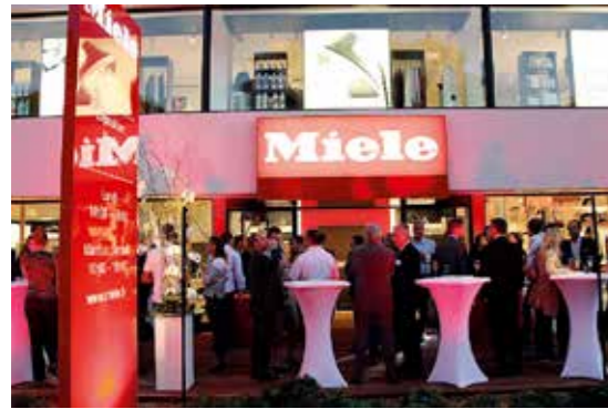
1 - La façade du Miele Center Nice, à Saint-Laurent-du-Var.
