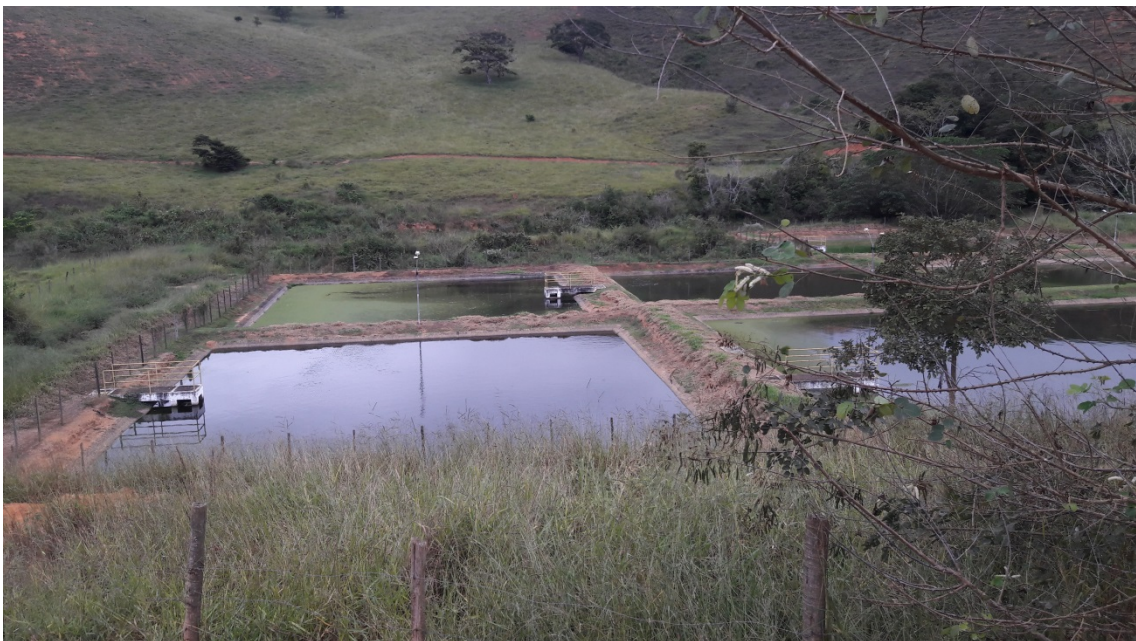
ESTAÇÃO DE TRATAMENTO DE ESGOTO – ETE
