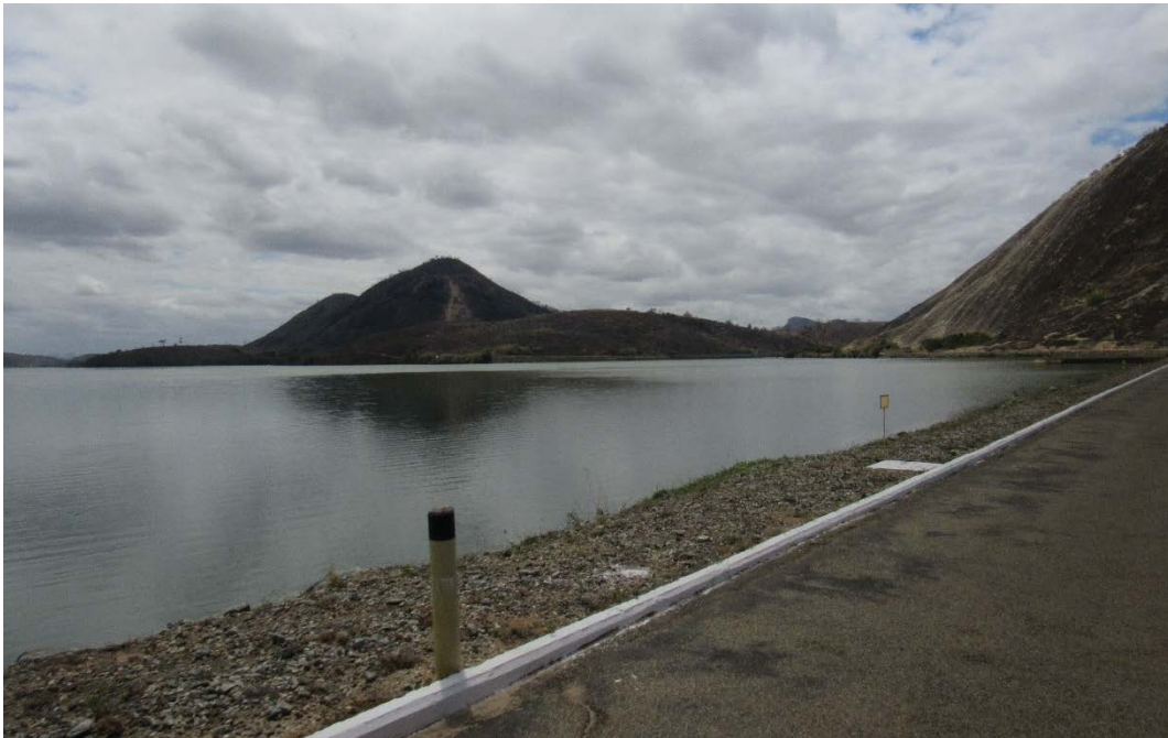
margem da barragem de aimorés
