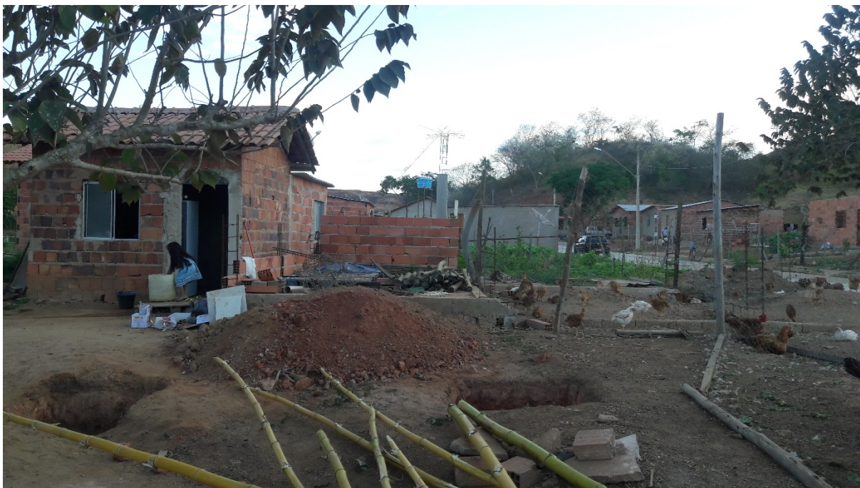
Ocupação condomínio ituetá
