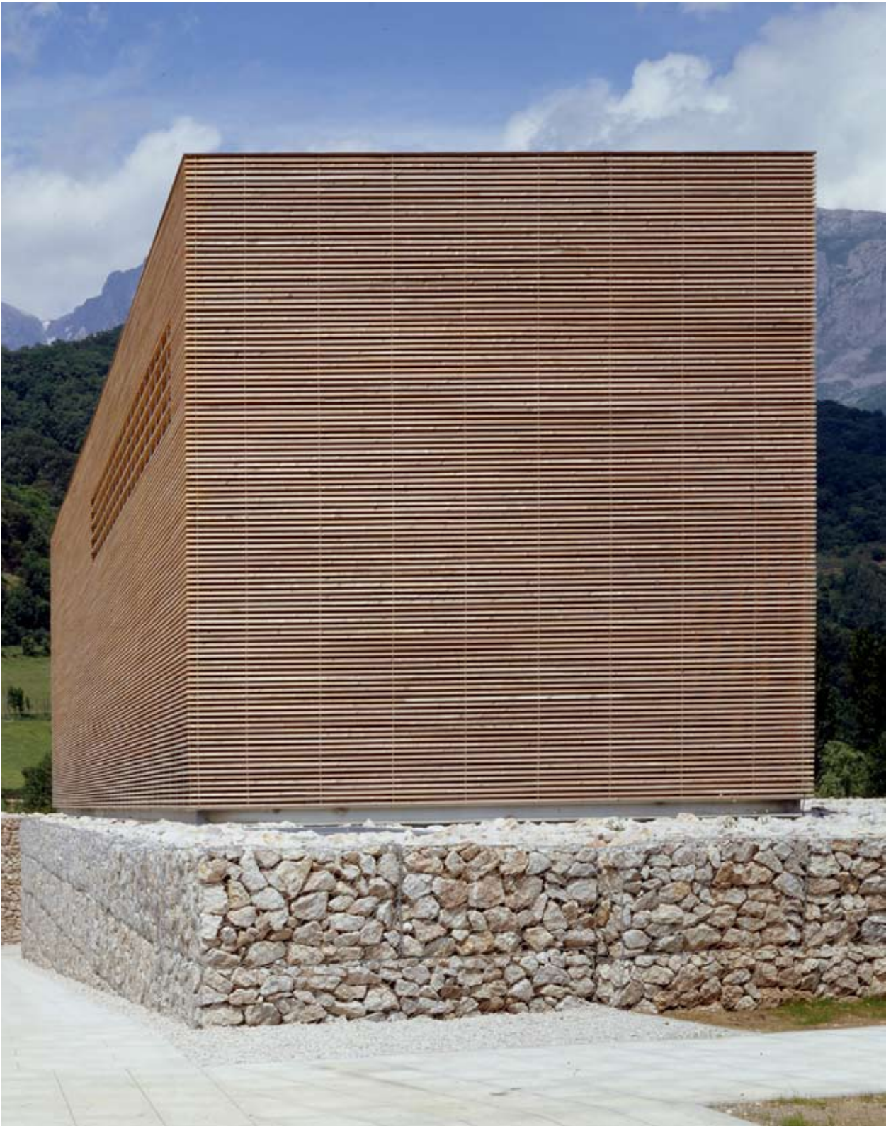
Centro de Interpretación de la Naturaleza en Picos de Europa. Arquitectos: Conrado Capilla y Pucho Vallejo
