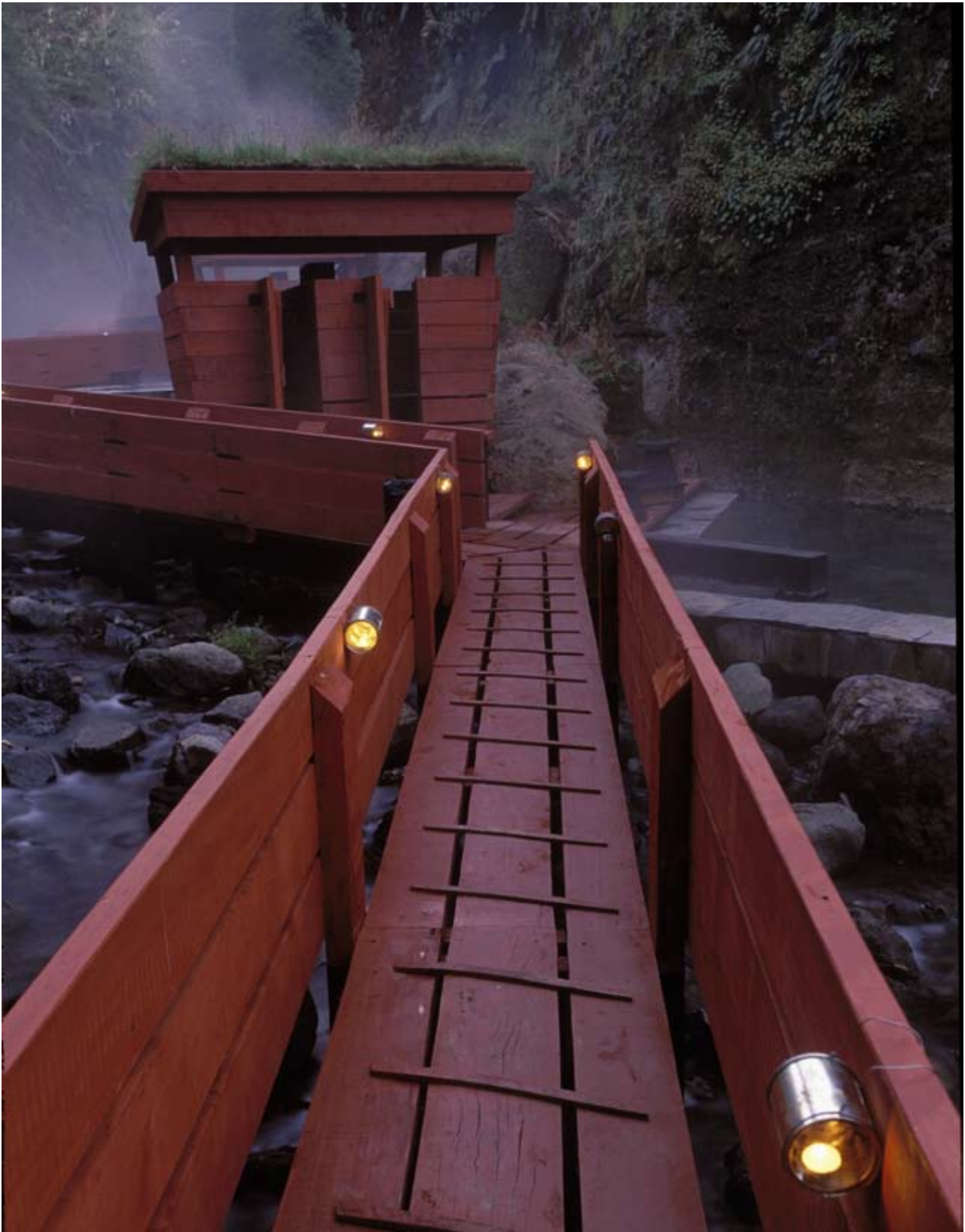
Termas geométricas (Chile) protegidas mediante pintura. Arquitecto Germán del Sol
