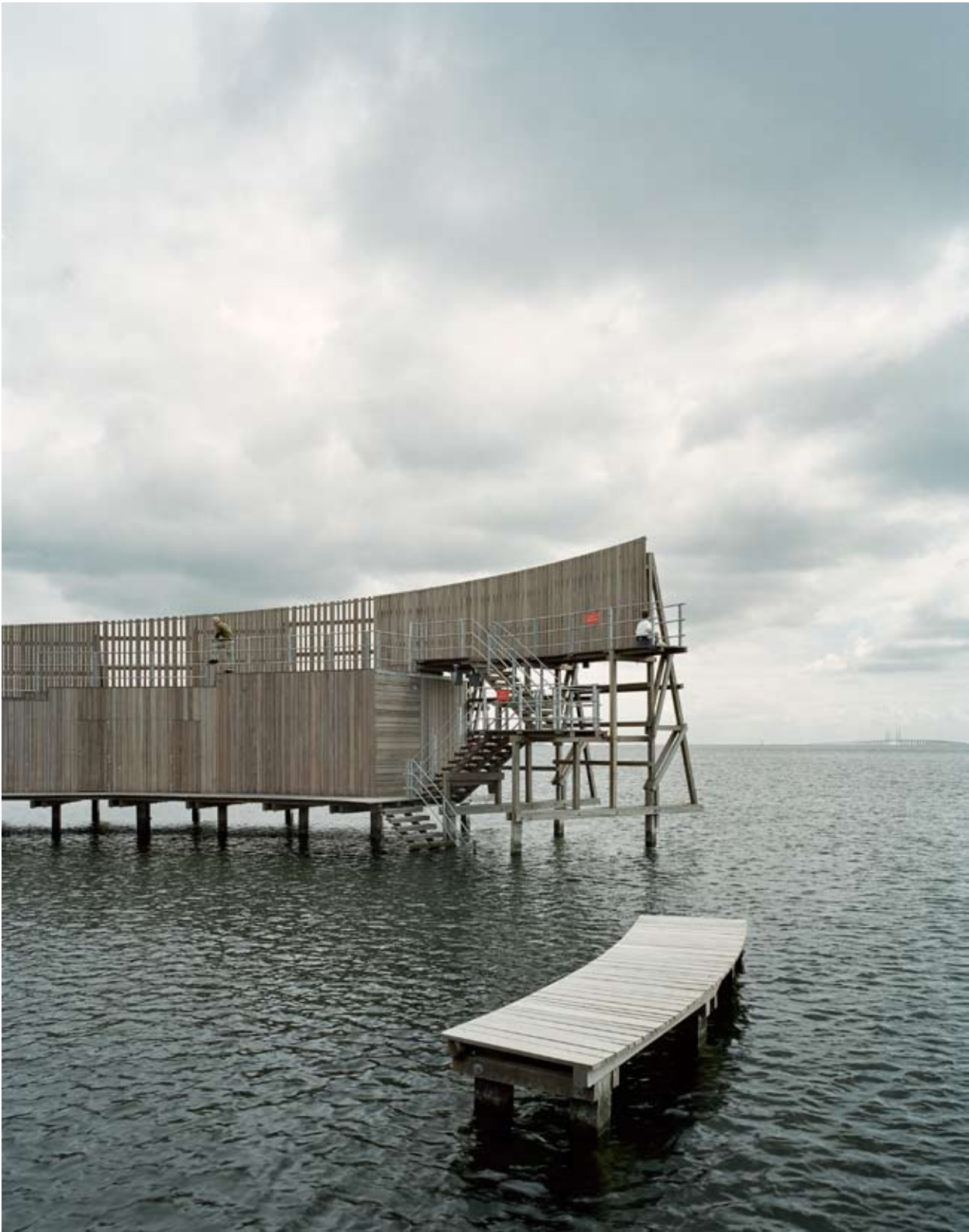
Pilotes para pantalán en Kastrup (Suecia). Arquitectos White Arkitekter
