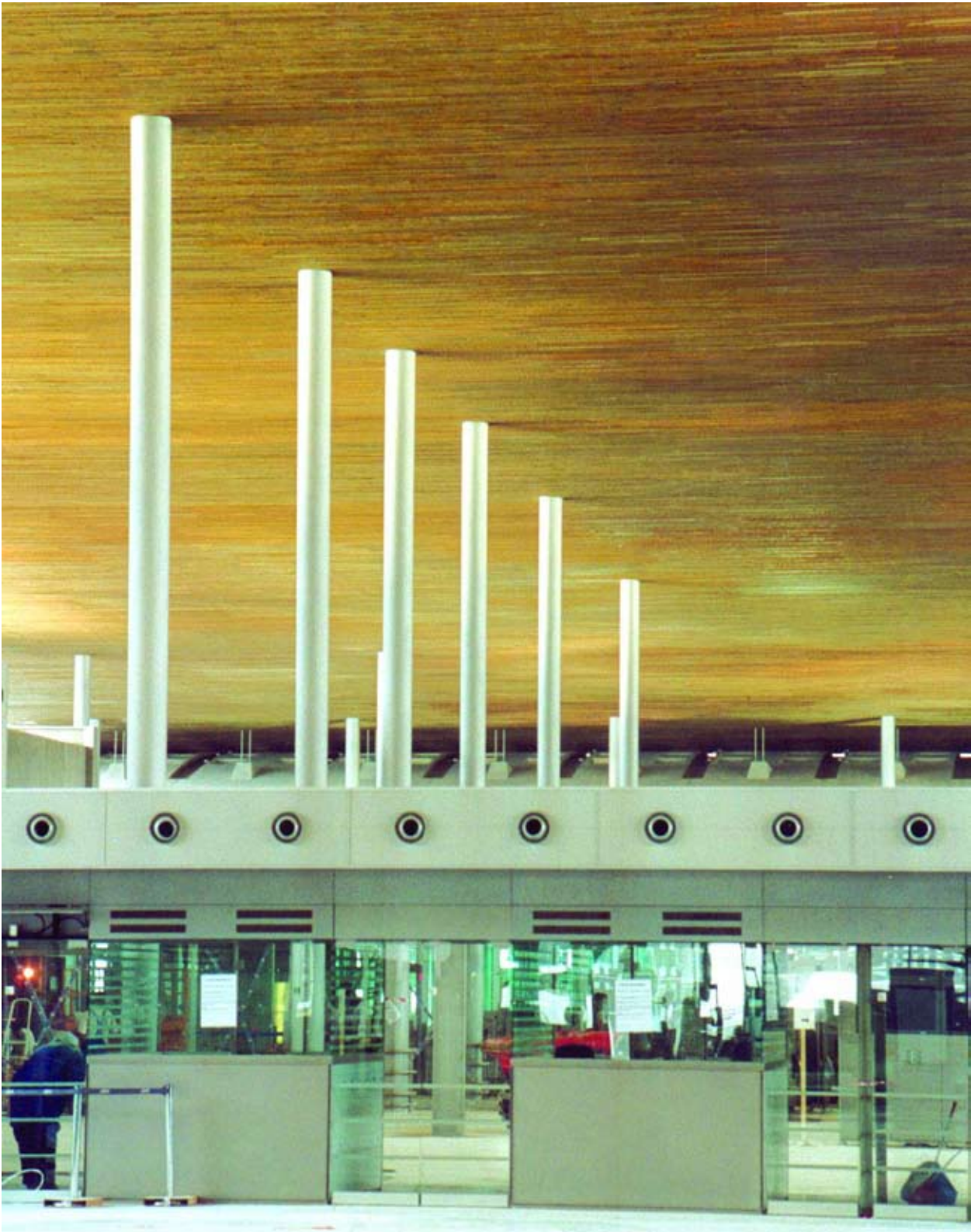
Techo de madera de Ayous tratada para ignifugar en el aeropuerto Charles de Gaulle en Roissy (Francia). Arquitecto: Paul Andreu
