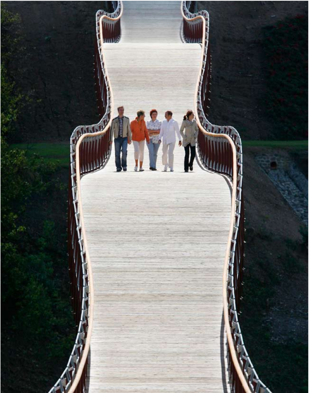
Pasarela peatonal en Thuringen (Alemania)
