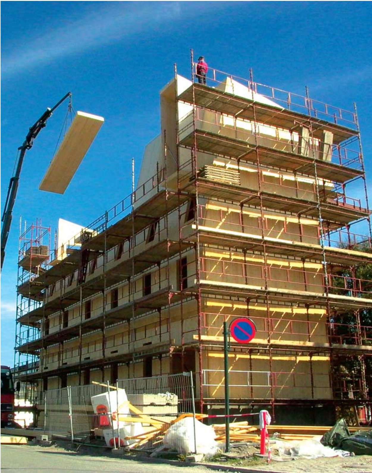
Estructura de tableros contralaminados en Trondheim (Noruega). Arquitecto: Brendeland y Kristoffersen
