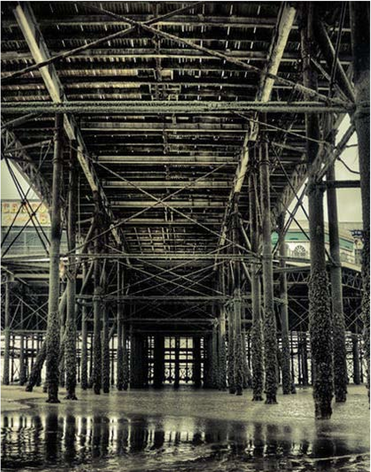
Pilotes aéros en el Balneario de Brighton (Inglaterra)
