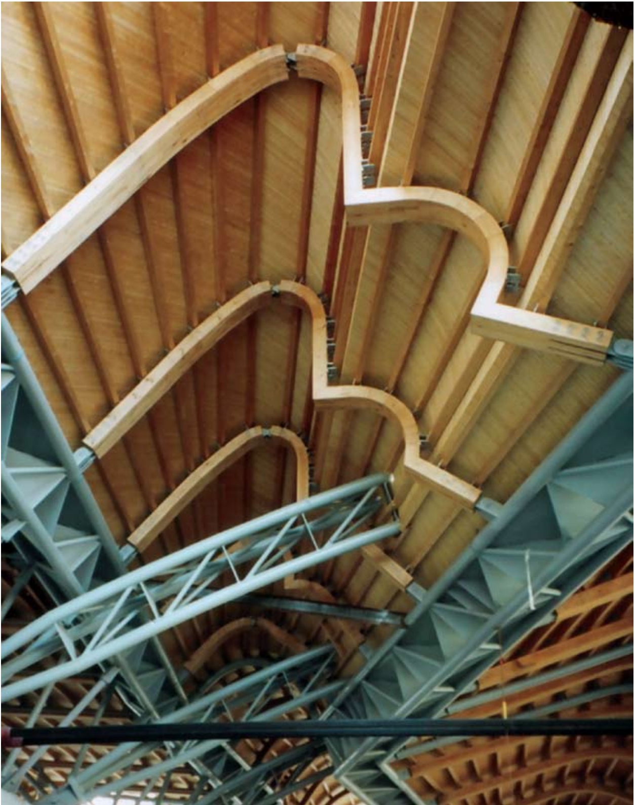
Mercado de Santa Caterina (Barcelona). Arquitectos: EMBT
