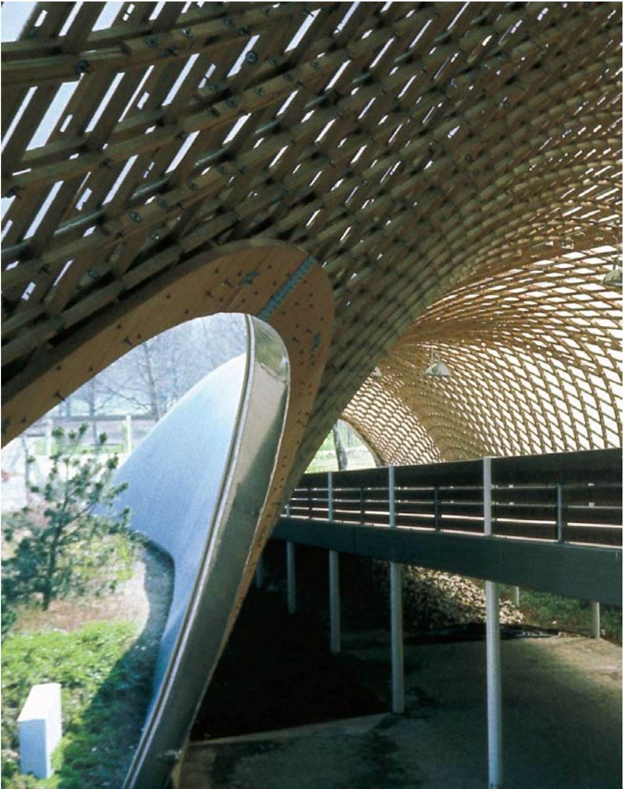
Techo para una nave multiuso en Mannheim. Arquitecto Frei Otto
