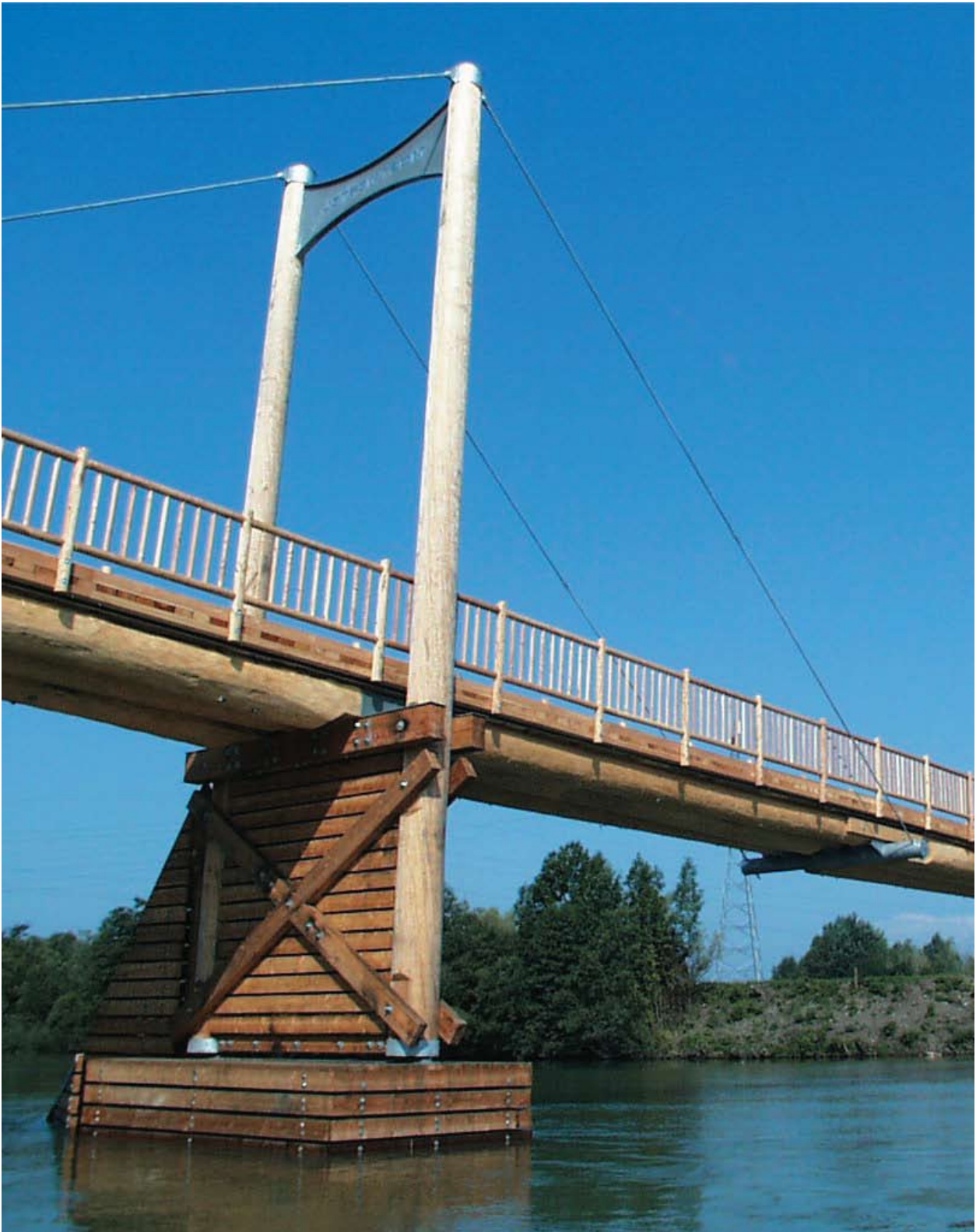
Puente entre San Panaleón y Erla (Austria)
