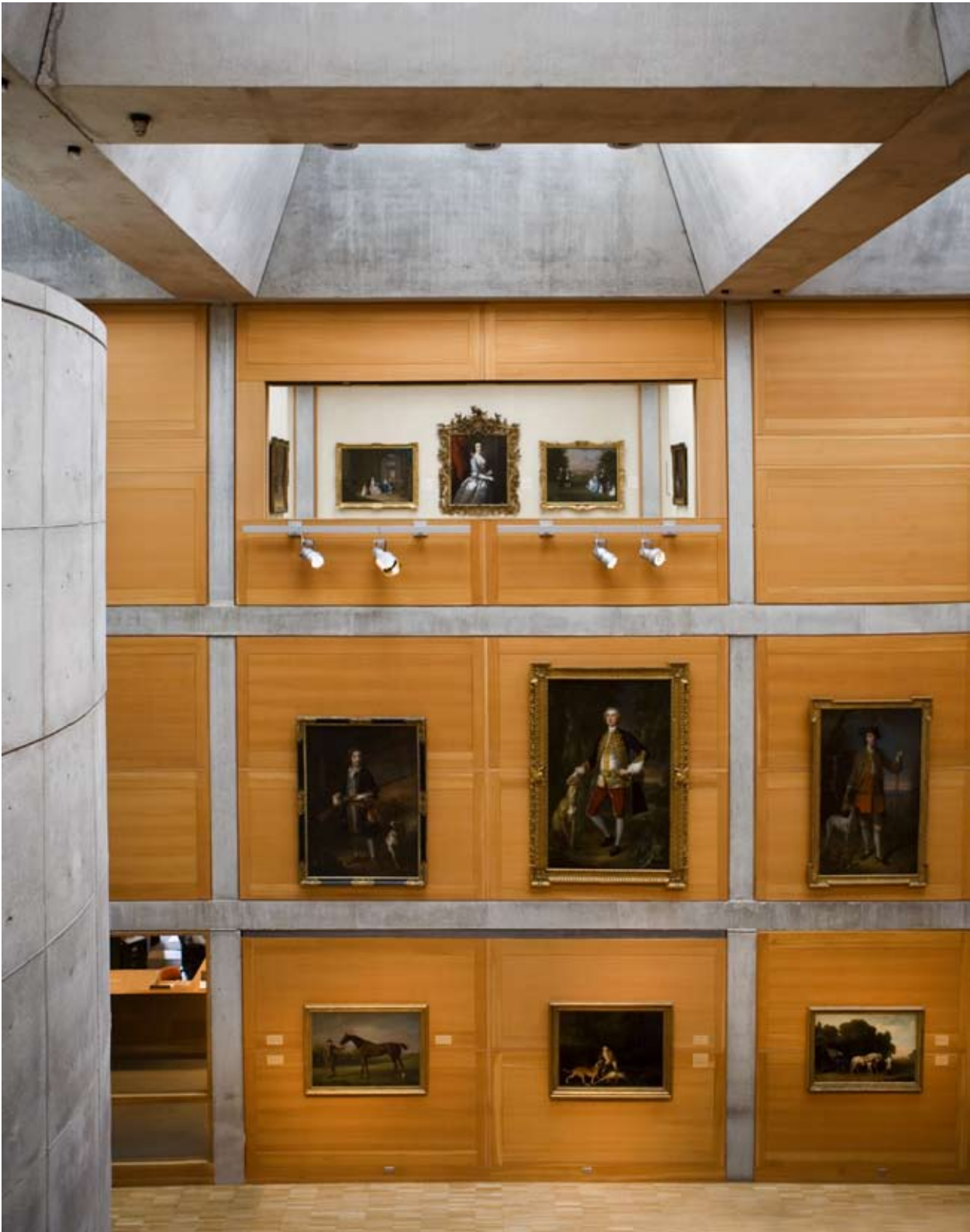
Paneles de madera rechapada en el Yale Center for British Art (New Haven, Connecticut, 1969). Arquitecto: Louis Kahn
