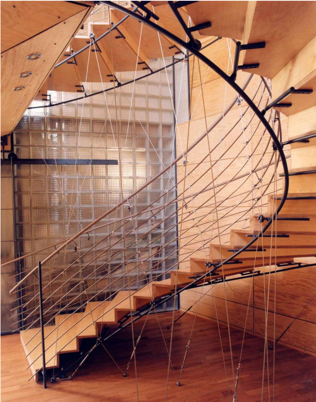
Escalera a base de tablero contrachapado y redondos tensados. Casa Tas (Finlandia). Arquitecto: Jirky Tasa
