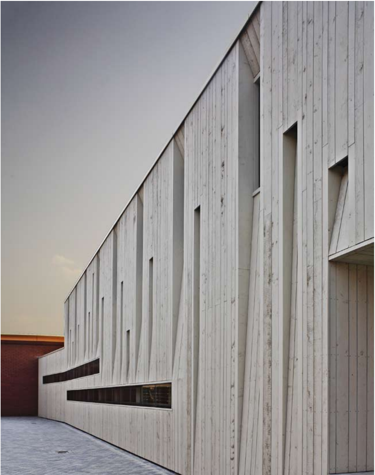
Centro peintenciaro Doggershoek (Holanda). Arquitecto: Loof & van Stigt
