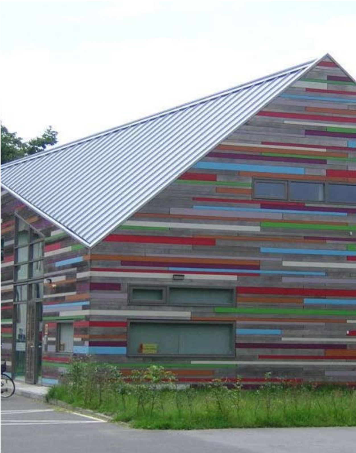
Guardería infantil en Rotterdam (Noruega). Arquitectos: Drost + van Veen
