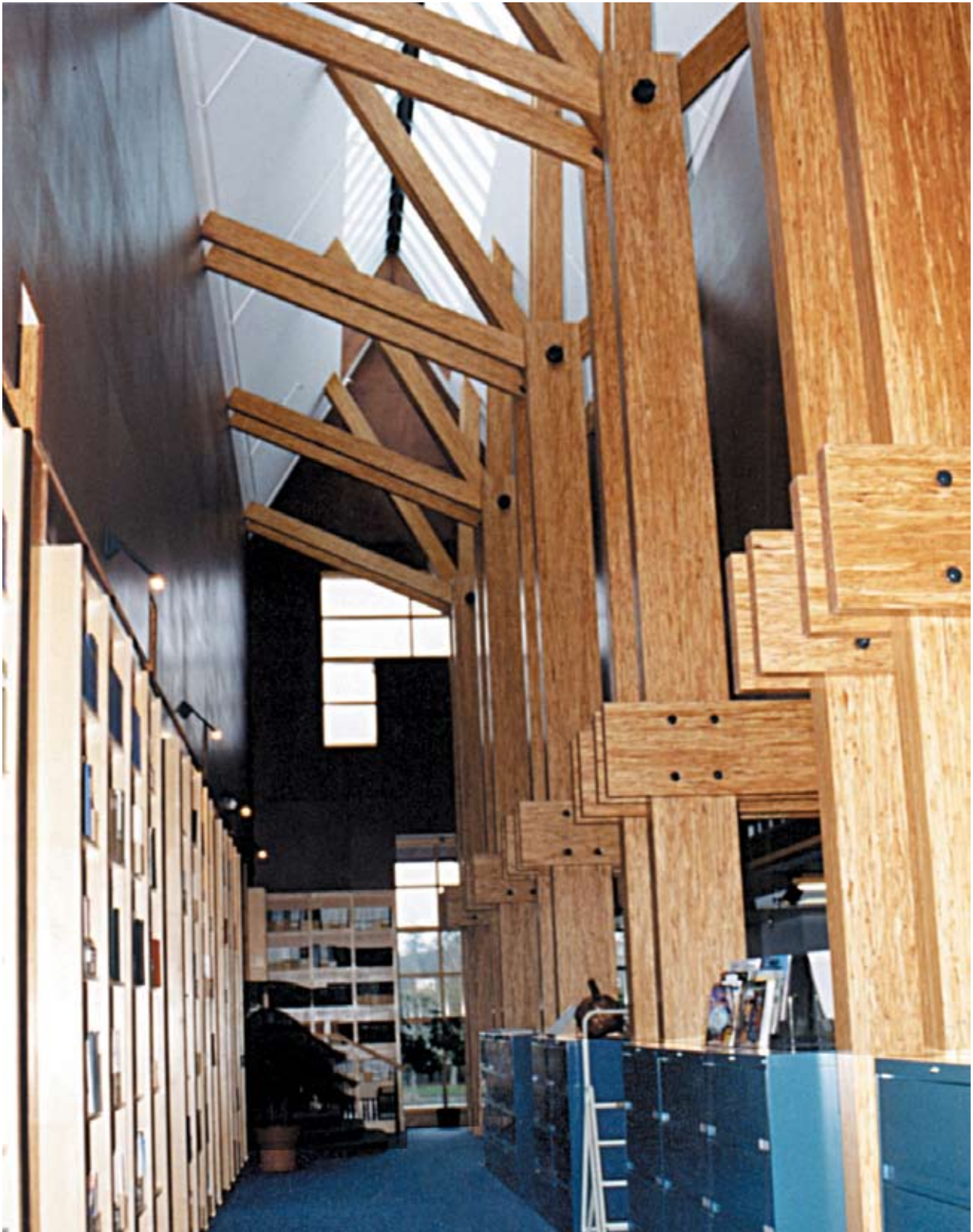
Pilares y codales de PSI. Laboratorio Forintek en Vancouver (British Columbia, Canadá). Arquitecto: Rick Hulbert
