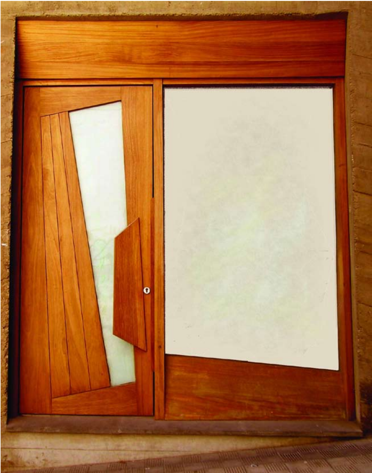
Puerta entablada en el edificio de viviendas Proa (Sta. Cruz de Tenerife). Arquitectos: AmP Arquitectos
