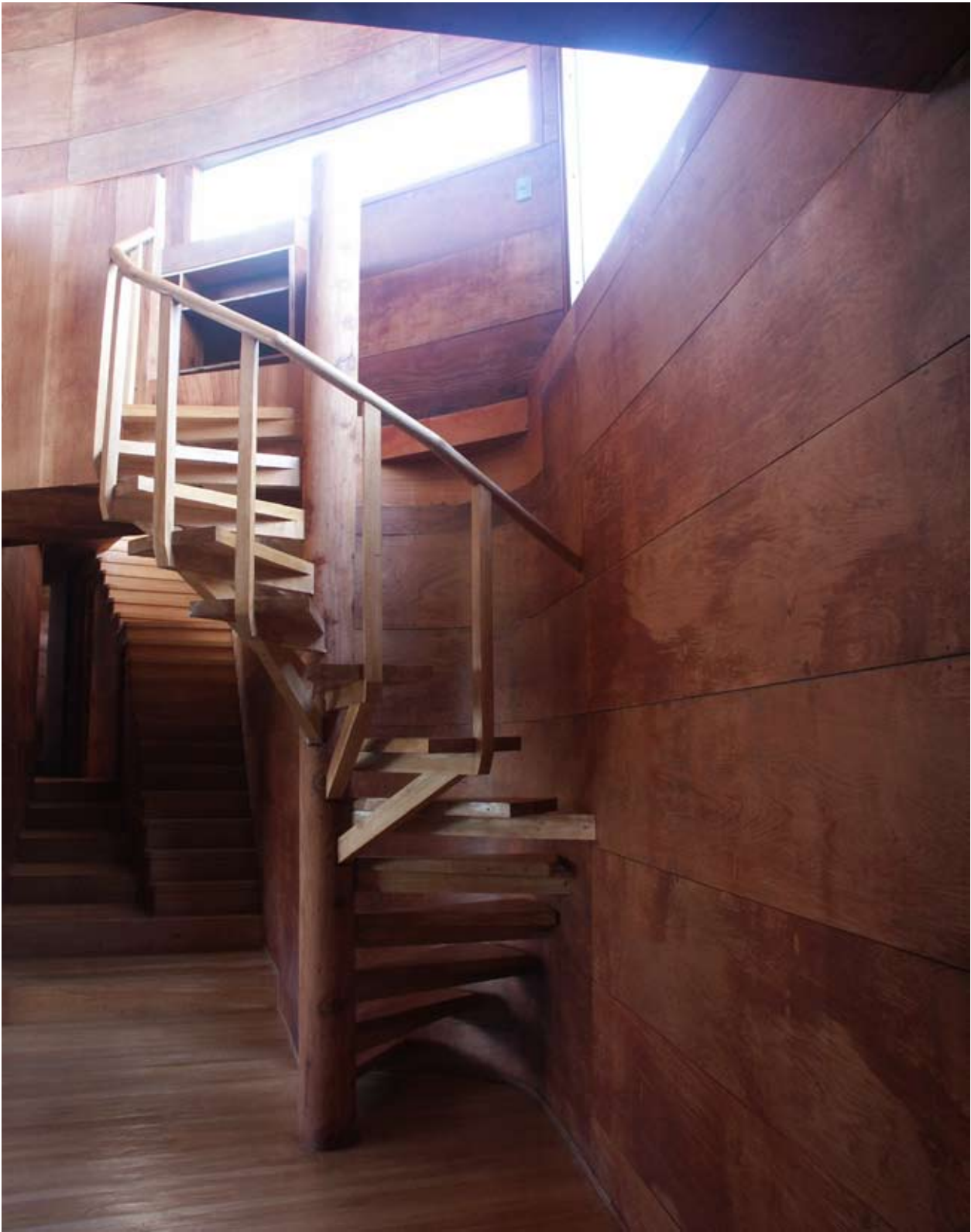
Escalera de caracol de coigüe en vivienda unifamiliar en Chamiza (Chile). Arquitecto: Jorge Lobos
