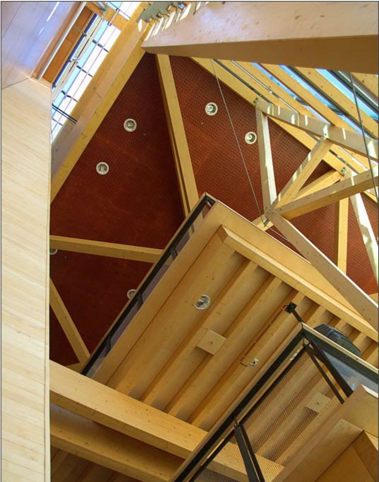
Pilares y codales de LVL en el Sibelius Hall, Lahti (Finlandia). Arquitectos: Artto Palo y Rossi Tikka
