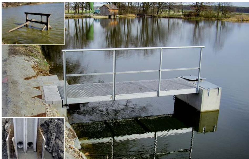
Dva sdružené požeráky se dvěma novými výpustními rourami pro manipulaci s velkou vodou na rybníku Dubenský (k. ú. Dubné u Českých Budějovic) pod silnicí 2. třídy, akce dotovaná Krajským úřadem Jihočeského kraje v roce 2009 jako protipovodňové opatření (foto P. Hartman)
