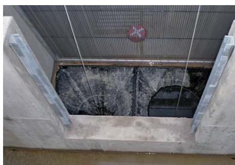
Odkalovací kužely ve vypuštěné odchovné nádrži (Žďár nad Sázavou)
