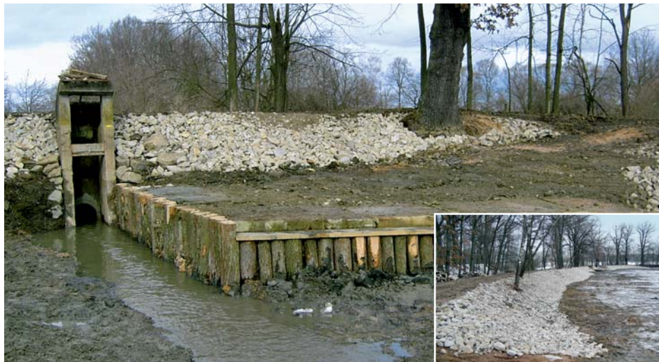
Rybník Ryšávek (k. ú. Třebín-Dubné) po odbahnění z dotačního titulu 129 130 MZE ČR, oprava kářiště, výpustní roury vyvločkováním a opevnění návodní strany hráze, údržba trvalé vegetace v r. 2006 (foto P. Hartman)
