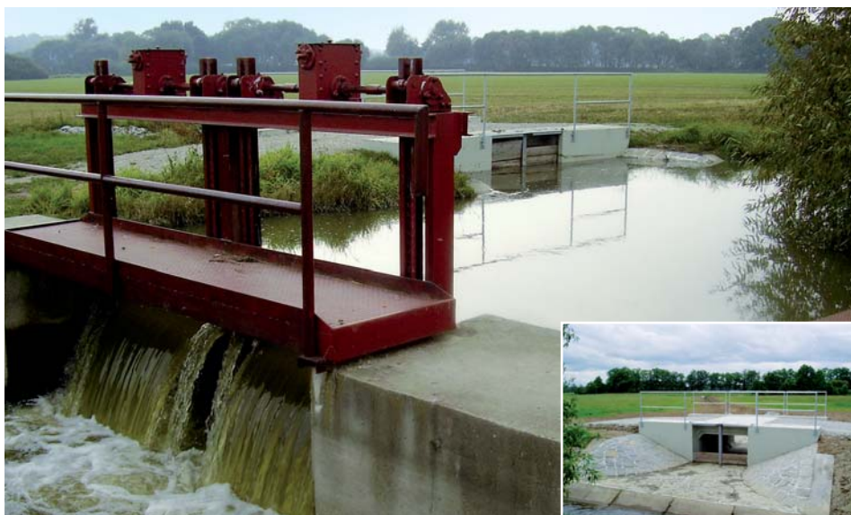
Dehtářský potok vyhrazený novým dvoutubulovým splavem k dělení vody vpravo do stoky Siloe pro přírodní rezervaci Vrbenské rybníky a vlevo pro rybník Čejkovický a Dasenský. Dělicí objekt a stavidlo byly budovány pomocí finanční podpory z protipovodňových opatření KÚ pro Jihočeský kraj a Magistrátu města České Budějovice, rok 2005 (foto archiv Lesy a rybníky města Českých Budějovic s.r.o.)
