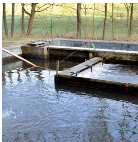
Airlift v zemním pstruhovém rybníce s instalovanou přepážkou (Heřmánkovice)
