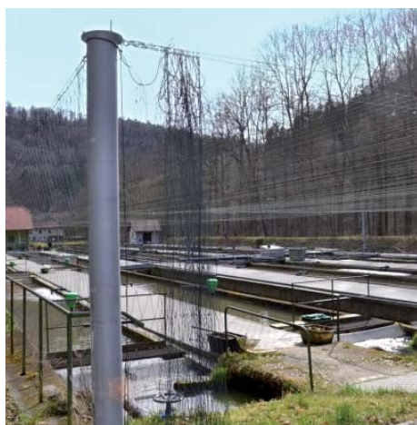
Sítové zakrytí areálu farmy proti rybožravým ptákům (Skalní mlýn)
