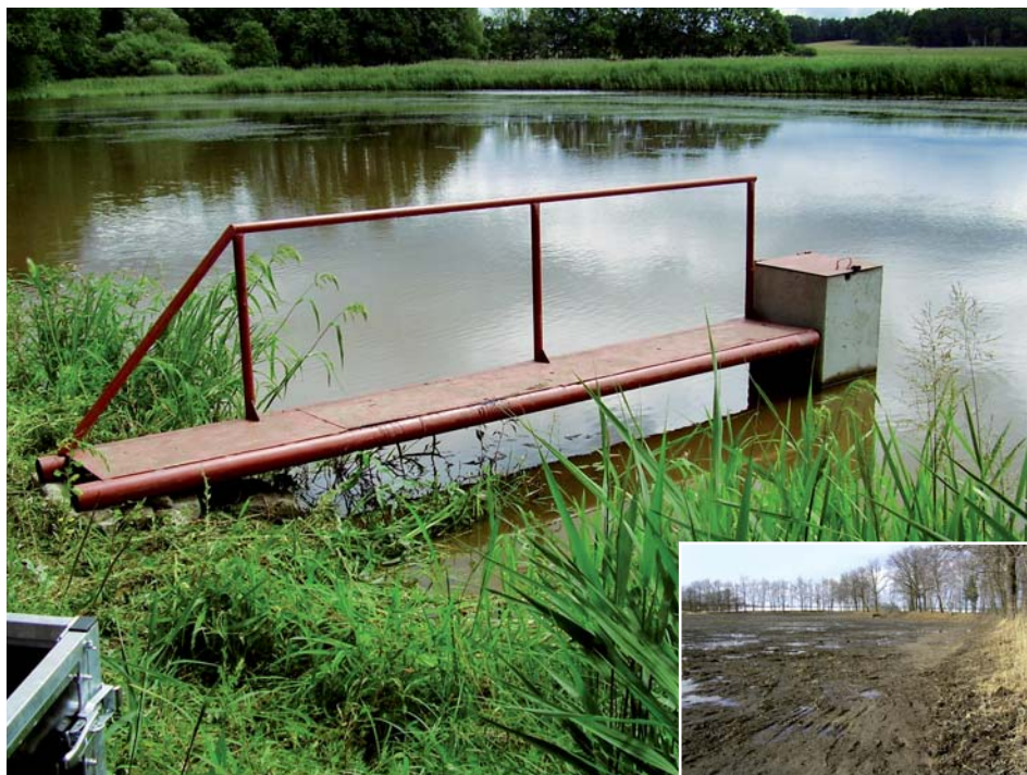
Rybník Rahovec Horní (k. ú. Třebín-Dubné) po odbahnění a revitalizaci (výměna výpustního zařízení) s bohatým litorálním pásmem rákosin (z titulu OP MŽP - zlepšování vodohospodářské infrastruktury a snižování rizika povodní r. 2005-2006) (foto P. Hartman)
