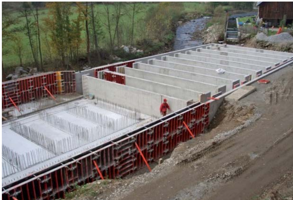
Výstavba prvního recirkulačního systému dánského typu v ČR (Mlýny u Vacova)
