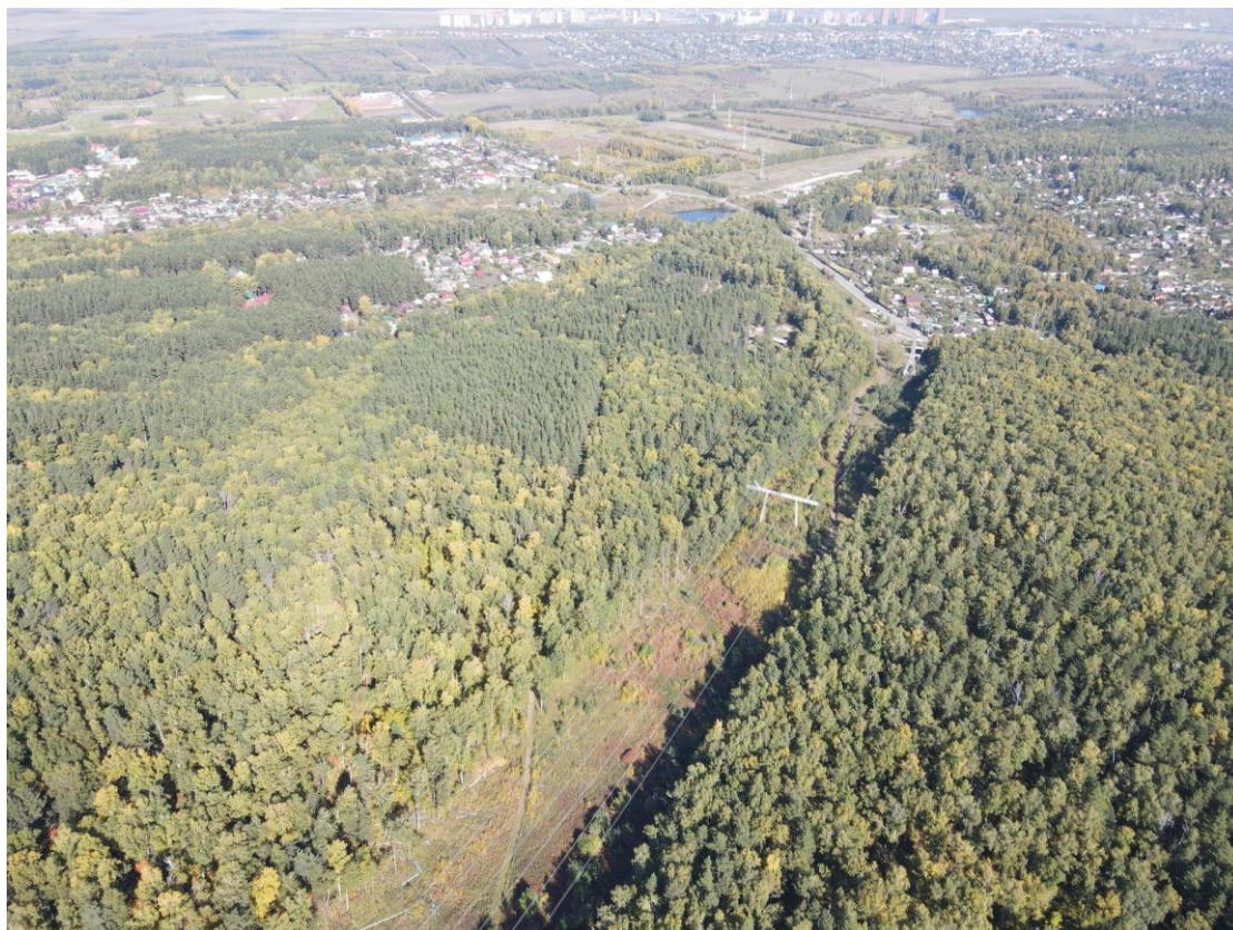
Рис. 4.28 Просека ВЛ 220 кВ Д-11/Д-12 "Дивногорская - Новокрасноярская". Фото БПЛА
