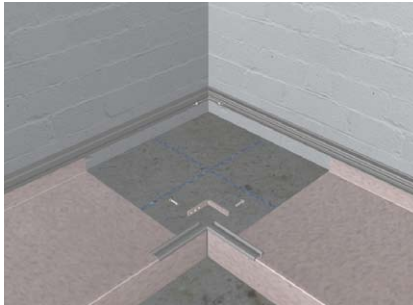
Kanalverbinder verschrauben
