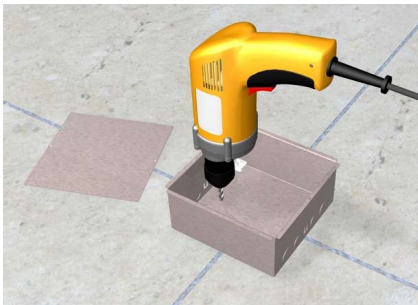
Blechgehäuse auf Rohdecke befestigen
