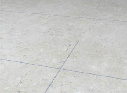
Kanalverlauf markieren
