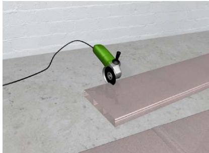
Kanäle bei Bedarf schneiden
