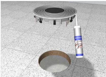
Versorgungseinheit abdichten
