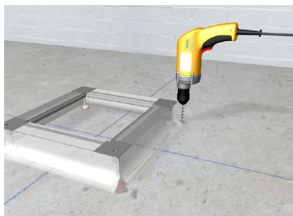
Zug- und Abzweigdose UDH... befestigen
