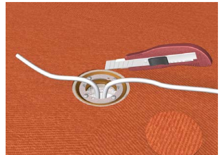
Bohrlöcher freischneiden
