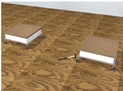
Dosen nach Verlegeplan positionieren
