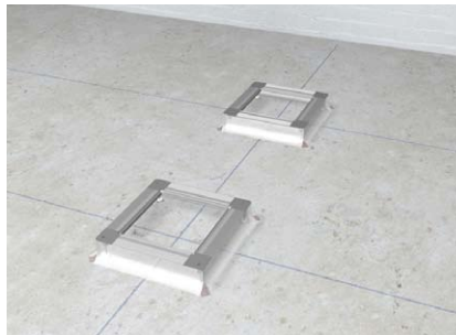
Dosen nach Verlegeplan positionieren
