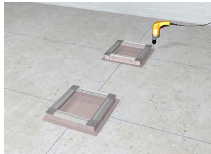
Dosen nach Verlegeplan positionieren
