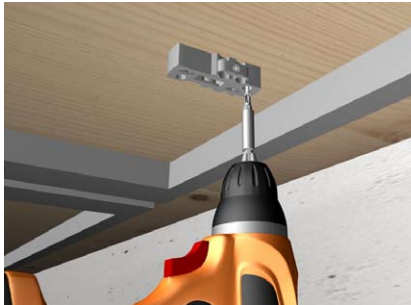
Anschlussadapter anbringen
