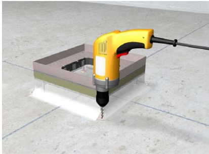
Kassettenrahmen befestigen
