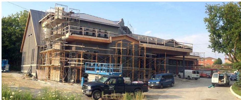
Az épülő torontói imaház. Rendszeresen könyörögjünk az építkező gyülekezetért!
