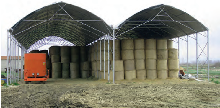
Εικόνα 21. Χώρος αποθήκευσης χονδροειδών ζωοτροφών. Παράδειγμα ελαφριάς κατασκευής.
