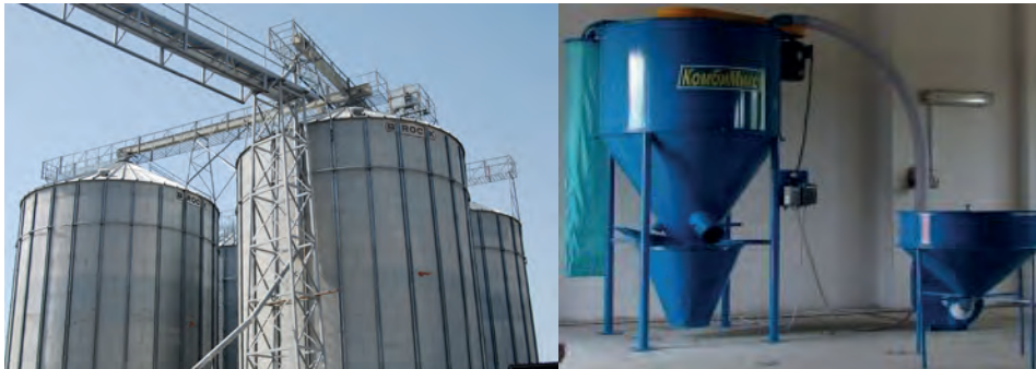
Εικόνα 22. Αριστερά χώρος αποθήκευσης συμπυκνωμένων ζωοτροφών, δεξιά χαρμανιέρα ανάμιξης φυράματος.
