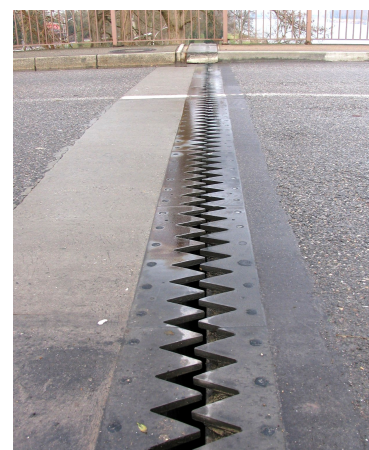
Fig. 4.12: Junto de dilato sur ponto
