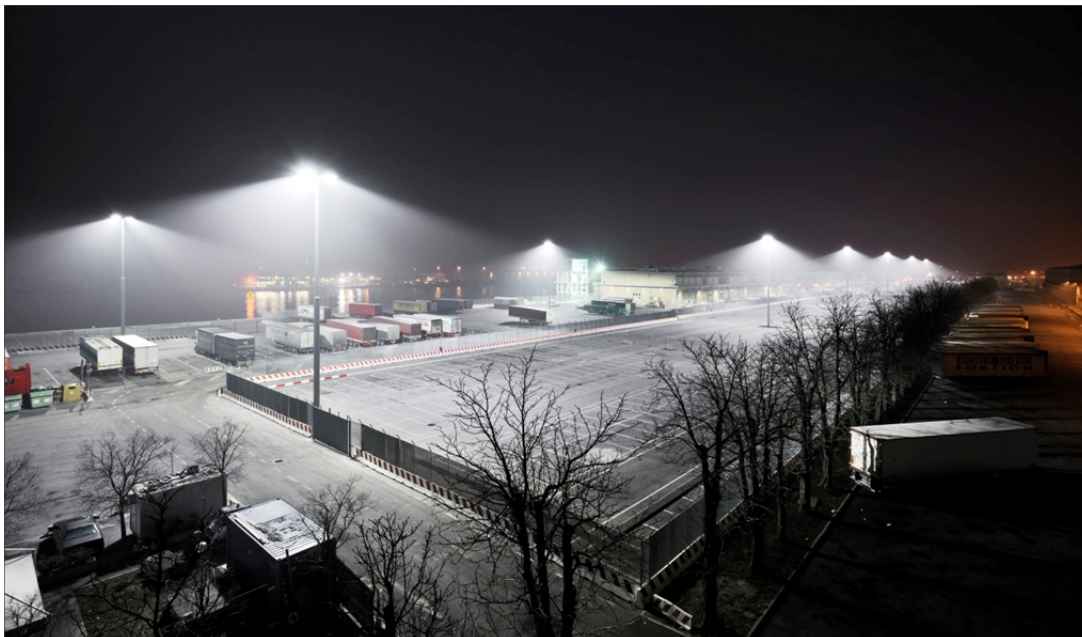
LED-Hochmastsysteme von ewo beleuchten den Hafen von Venedig
