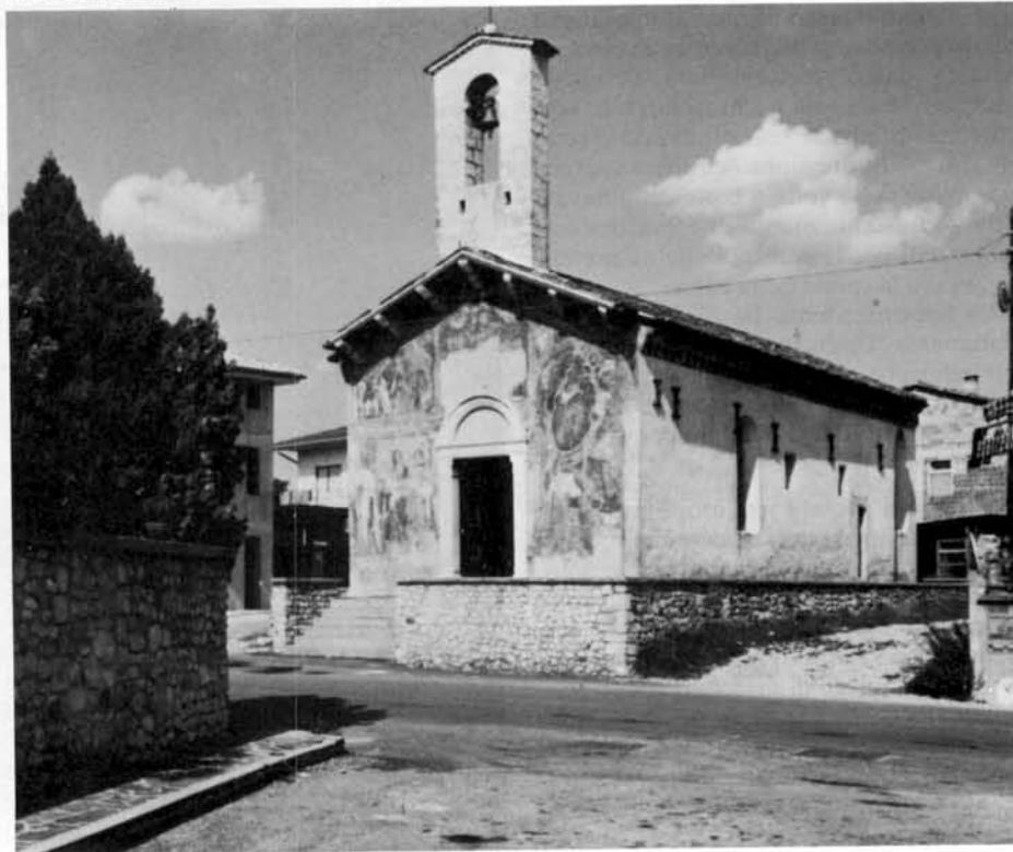
La chiesa di S. Maria dei Battuti dopo il restauro.
