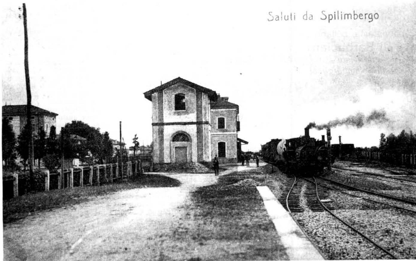
La stazione ferroviaria di Spilimbergo (lato nord) (coll. Luigi Zanin).
