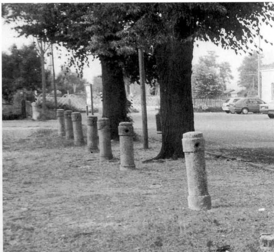
Particolare della fila dei colonnini di pietra artificiale attraverso i quali veniva passato il canapo a cui si legavano le bestie.
