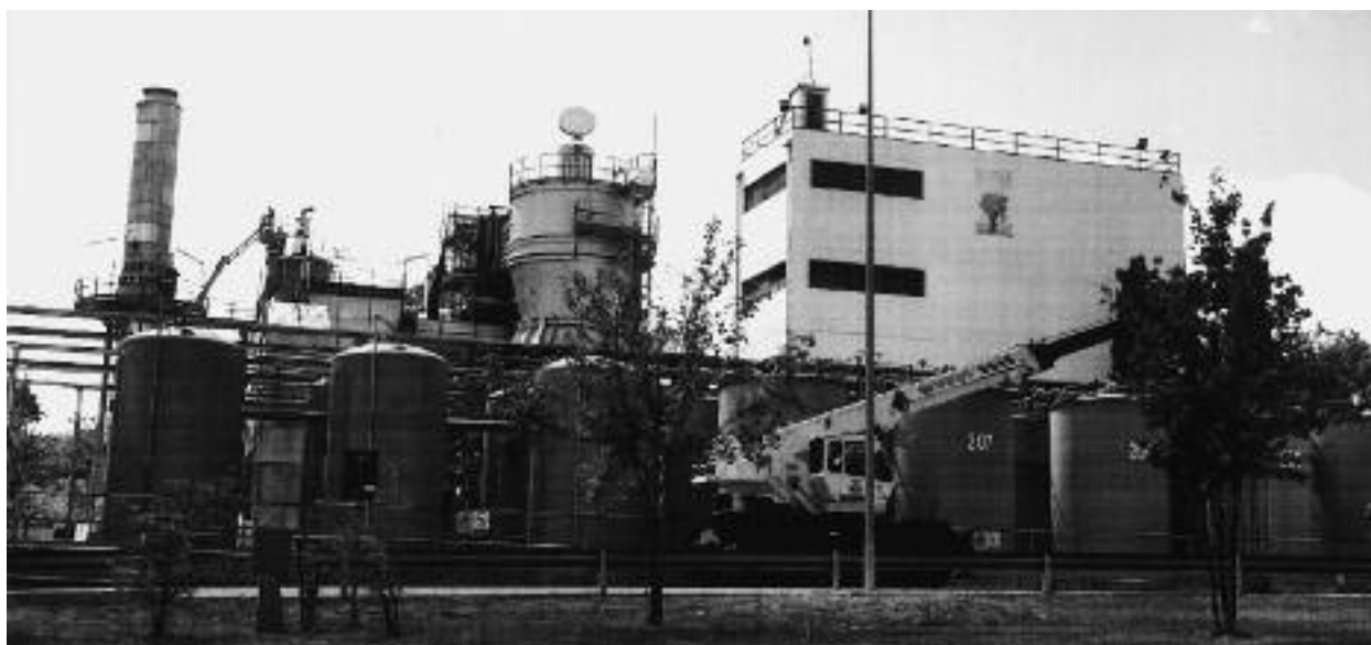
Il termovalorizzatore della Mistral Fvg nella zona industriale del Cosa. L'impianto brucia rifiuti speciali industriali e ospedalieri e, con il calore sviluppato, produce energia elettrica e acqua calda utilizzabile con il teleriscaldamento (foto Elisa Bisaro).
