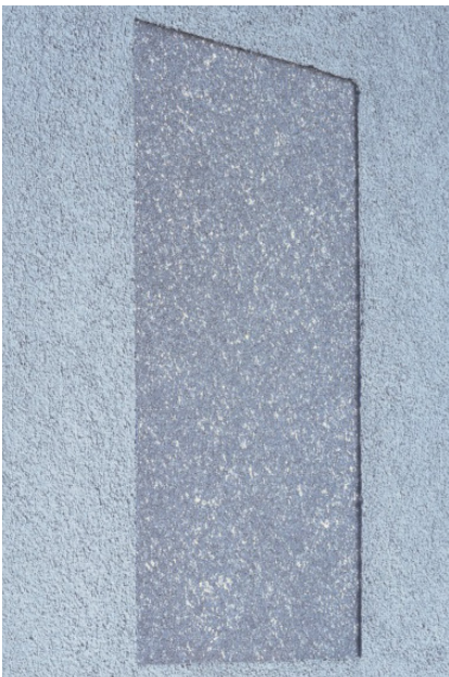
Esempio di intonaco con TIM a confronto con un intonaco di tipo tradizionale.
