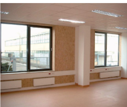
Zill + Lippe, Retrofit energetico di edificio per uffici , Erfurt, Germania, 2002. Viste esterne ed interne.
