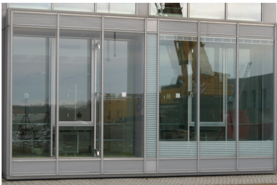
Test-room VERU (Versuchseinrichtung für Energetische und Raumklimatische Untersuchungen) dell'Istituto di Fisica dell'edificio del Fraunhofer Institut, Holzkirchen, Germania. Monitoraggio delle prestazioni in uso di due facciate realizzate con vetri dalle prestazioni termiche differenti.
