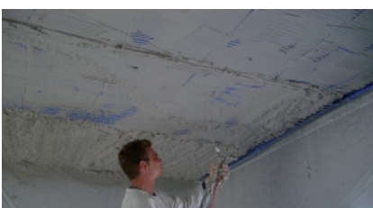
In alto: Intonaco contenete in Pcm integrato con un sistema di raffreddamento con tubi capillari testato presso l'Istituto Fraunhofer Ise di Friburgo, Germania.
