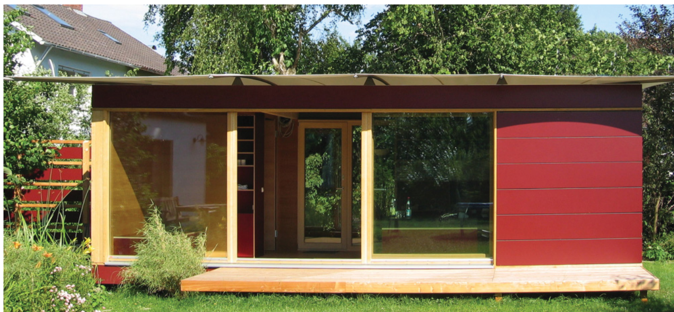
Manuela Skorka, Satellit - modulo abitativo prefabbricato realizzato con pannelli VIP.
