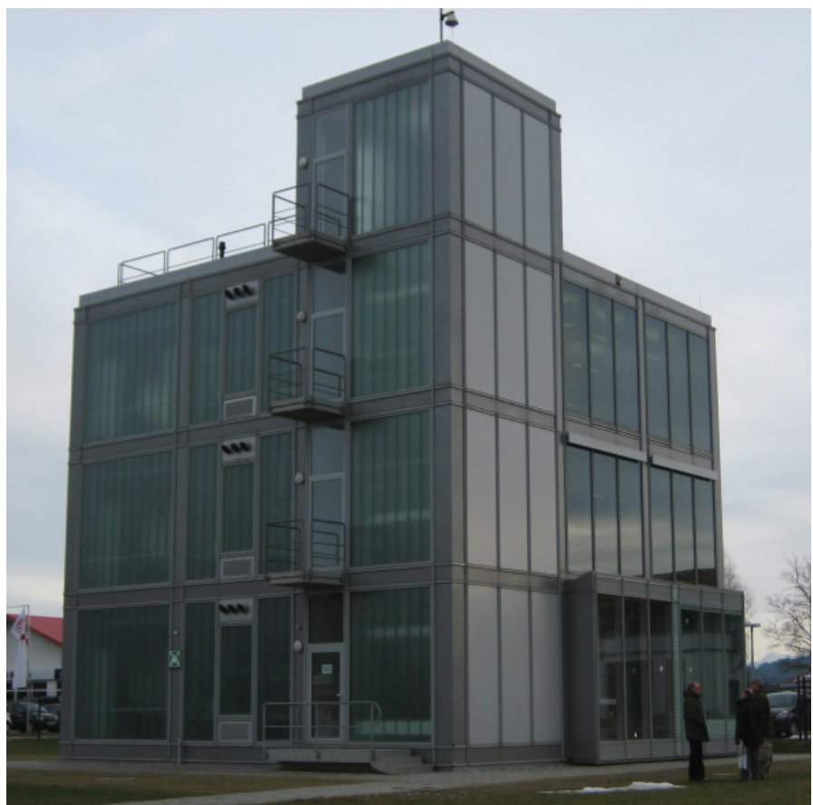
Test-room VERU (Versuchseinrichtung für Energetische und Raumklimatische Untersuchungen) dell'Istituto di Fisica dell'edificio del Fraunhofer Insitut, Holzkirchen, Germania.
