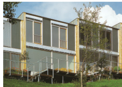
Walter Unterrainer, Case a schiera , Batschuns, Austria, 1997. Involucro stratificato a secco con collettori piani in facciata.
