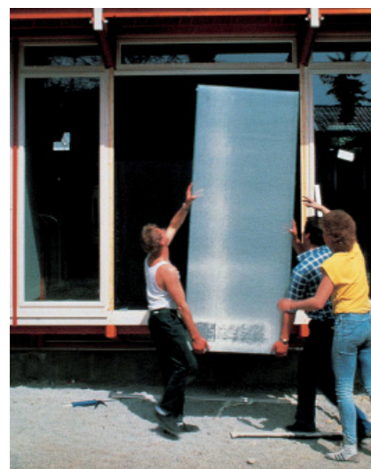
Thomas Herzog, Casa bifamiliare, Pullach, Germania, 1986-1989.
