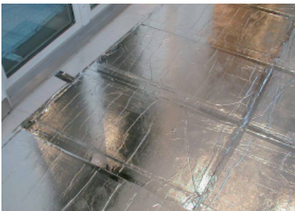
Applicazione dei pannelli VIP nella realizzazione di un solaio. Fonte: Va-q-tec, Würzburg, Germania.
