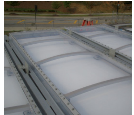
Prototipo di una copertura pneumatica contenente aerogel granulare. Fonte: Jan Cremers - SolarNext AG/Hightex Group, D-Rimsting.
