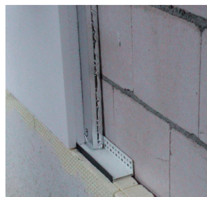
Applicazione dei pannelli VIP nella realizzazione di un solaio e una parete esterna. Fonte:Va-q-tec, Würzburg, Germania.
