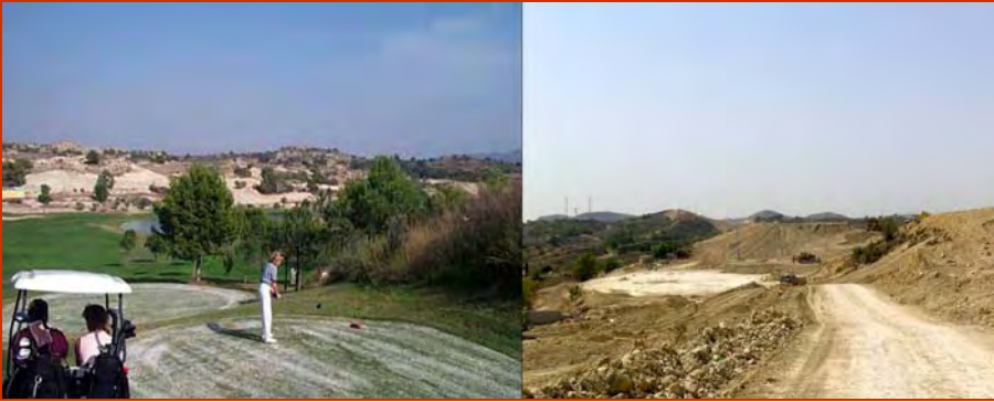
Fig. 3.- Principales riesgos que sufren las poblaciones de Vella lucentina . A la izquierda, imagen del campo de golf próximo a Orito, cuyo entorno está siendo transformado para la construcción de zonas residenciales. A la derecha, reciente construcción de viales (septiembre de 2005) en las inmediaciones de l'Alcoraia, a consecuencia de la cual se ha eliminado más de la mitad del principal núcleo poblacional conocido de la especie. Fotos: "Alenda Golf" ( web ) y M.B. Crespo.
