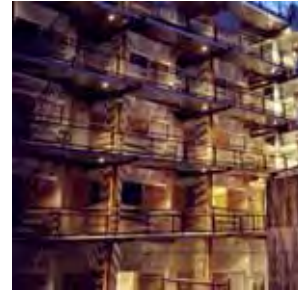
Accessos a través de passarel·les a l'edifici d'habitatges per a joves (Mataró).
