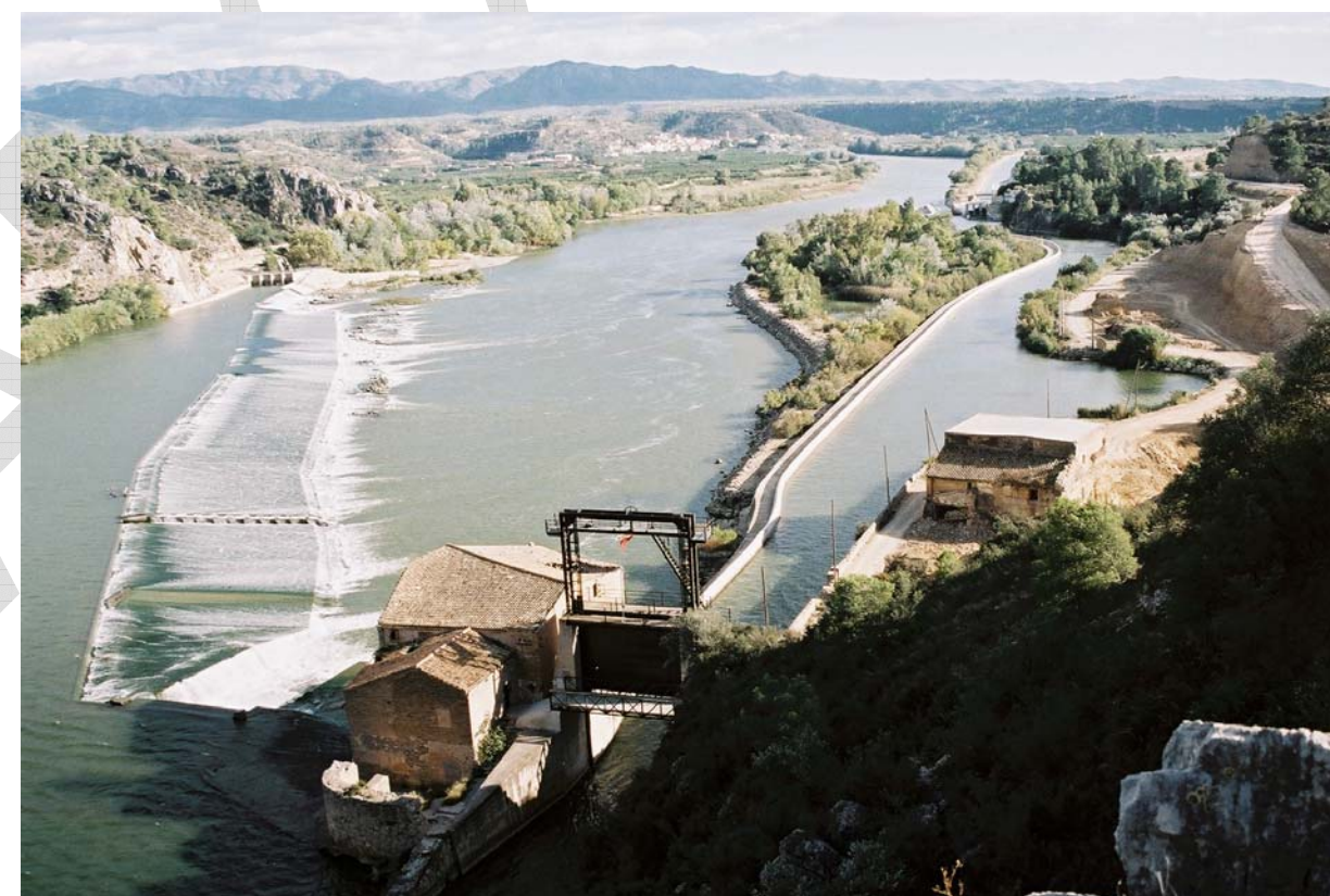
El Azud de Xerta es la construcción hidráulica más representativa de esa época. Las primeras obras documentadas comenzaron poco después del año 1148, cuando Ramon Berenguer IV logró conquistar Tortosa.
