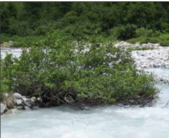
Fig. 8 - Situation en pied de berge.
