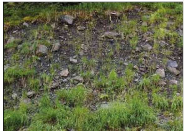
Fig. 7 - Situation sur loupe de glissement.
