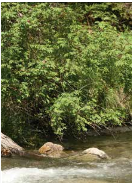
Fig. 8 - Situation en pied de berge.
