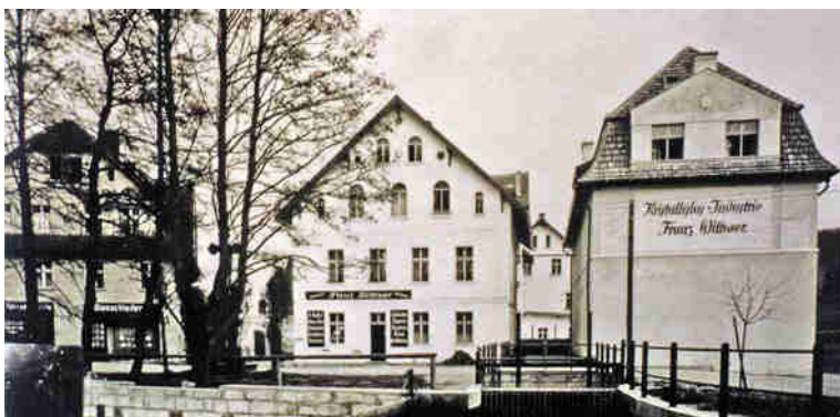
Das Ausweichquartier in der Pankratzschleife
