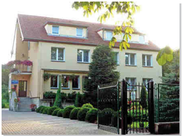
Der Neubau ul. Kamienna 9
