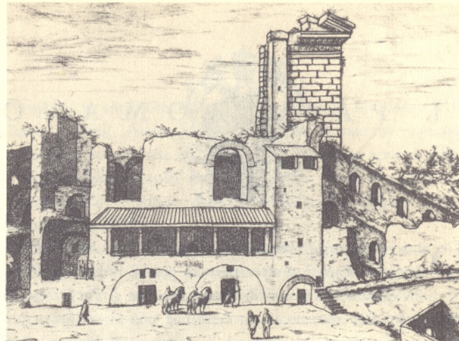
La torre Mesa nei giardini Colonna
