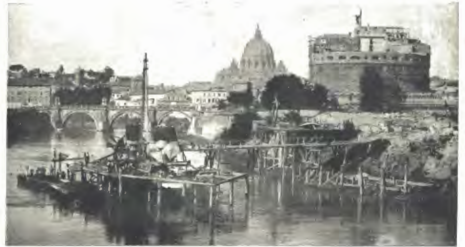
Fondazioni di Ponte Umberto.
