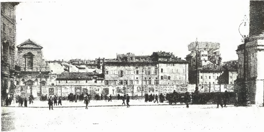
Area del Palazzo. Piombino dopo la demolizione.
