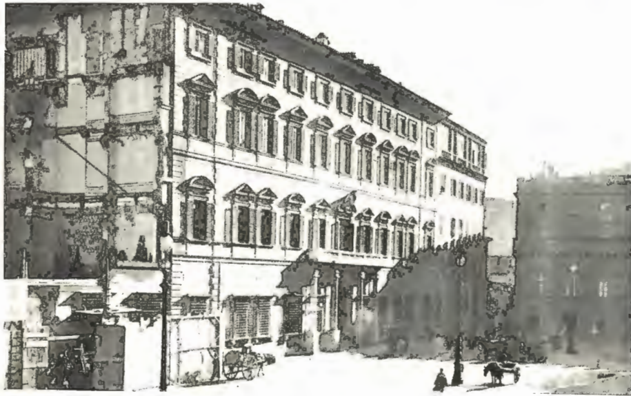
Palazzo Torlonia prima e durante le demolizioni.
