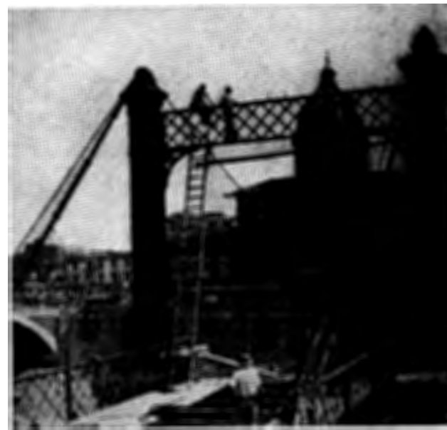
Il « ponte de fero » in demolizione (1941)
