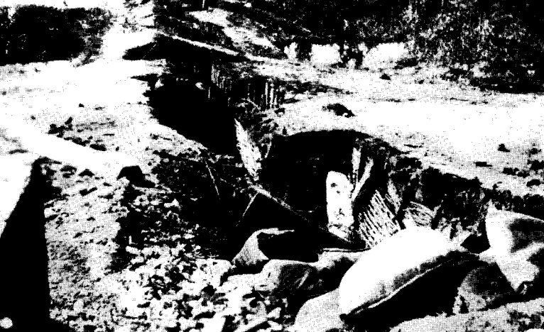
Rottura degli argini per effetto dell'acqua.
