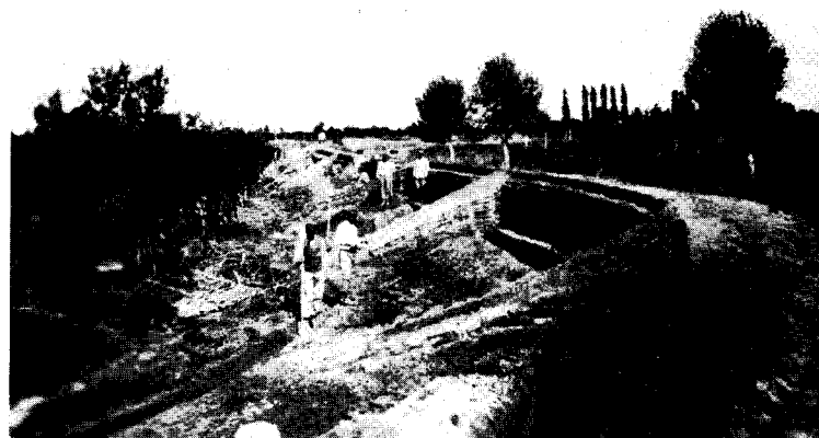
Trincee negli argini.
