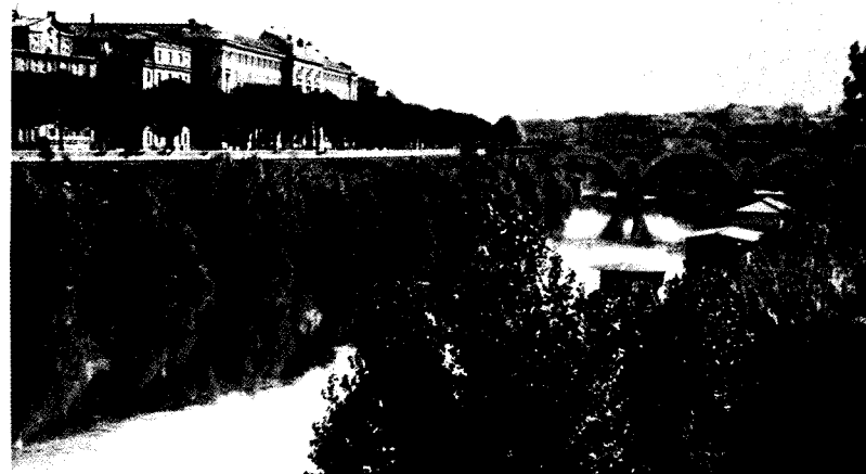
Il Tevere sotto Monte Mario (Ponte Duca d'Aosta): banchine e riva sottostante con molta vegetazione.
