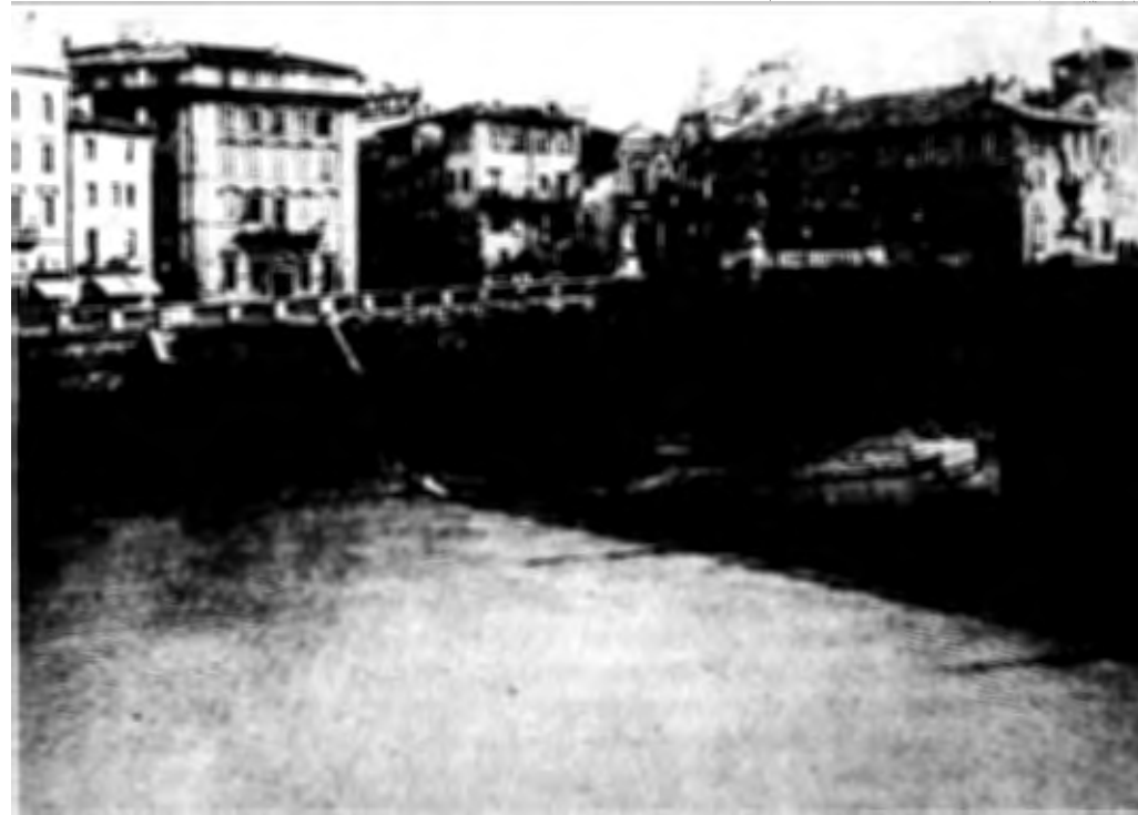
La piazzetta di Ponte prima dei lavori di costruzione dei muraglioni del Tevere. (Gabinetto comunale delle stampe)
