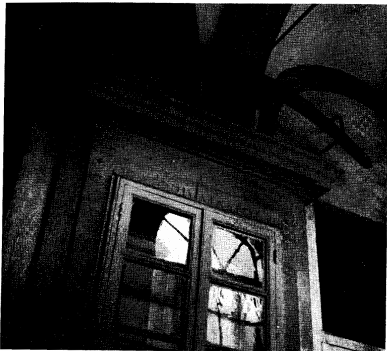
Ingresso dell'oratorio, particolare. Notare sull'architrave la data e in alto la grande costola di cetaceo.
