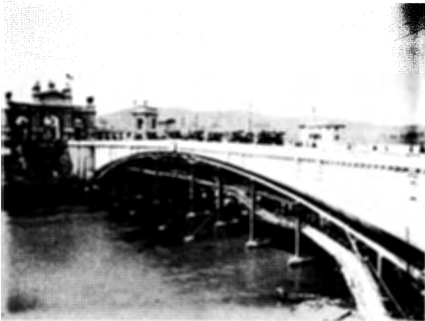
Ponte Risorgimento , di F. Hennebique, in fase di collaudo. (Sul fondo: l'ingresso monumentale al Foro delle Regioni, del Piacentini, poi smontato).
