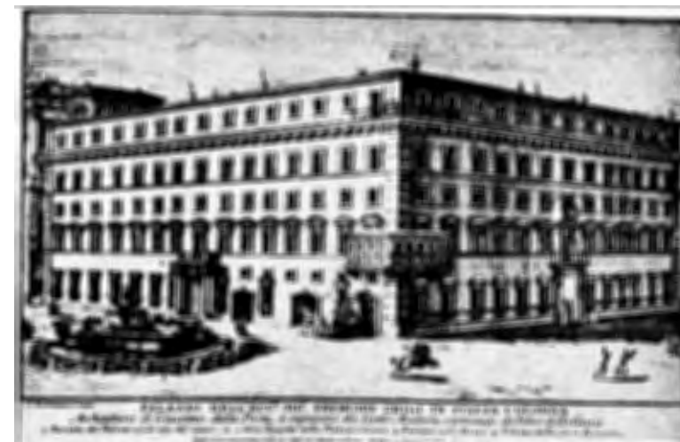
Palazzo Chigi: « architettura... finita da Felice della Greca ». Sopra: stampa del Falda. Sotto: stampa dello Specchi.
