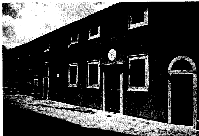
Castel Sant'Angelo, l'Armeria vista dal Cortile dell'Angelo dopo il rifacimento dell'intonaco (settembre 1993).
