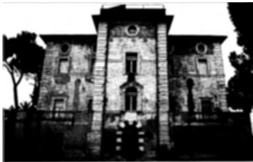
Prospetto del palazzo della villa.
